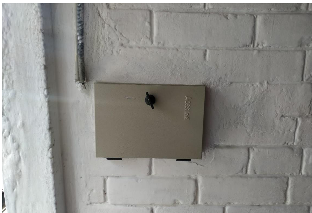
Figura 3.31 Acabado del tablero de distribución.
