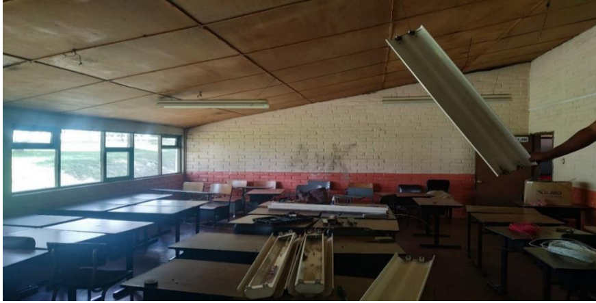
Figura 3.13 Retiro de luminarias.
