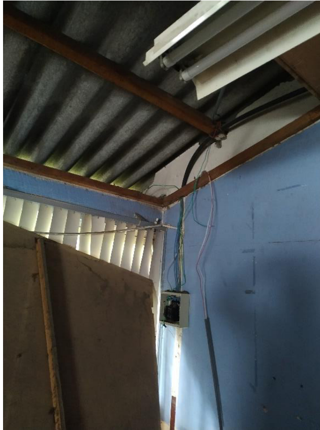
Figura 3.34 Desmontaje del techo de las aulas 7 y 8.
