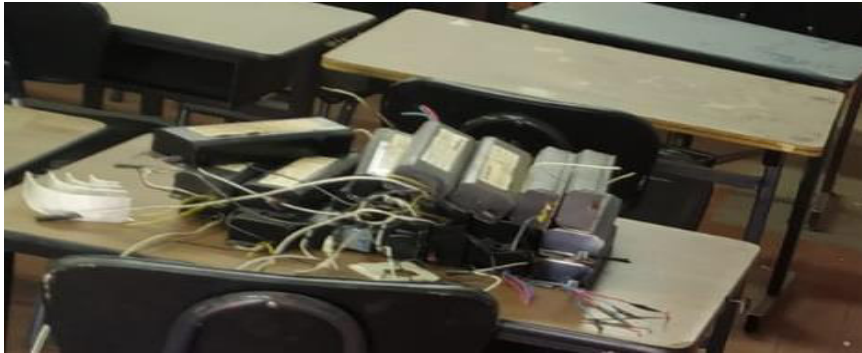
Figura 3.14 Balastos retirados de luminarias.
