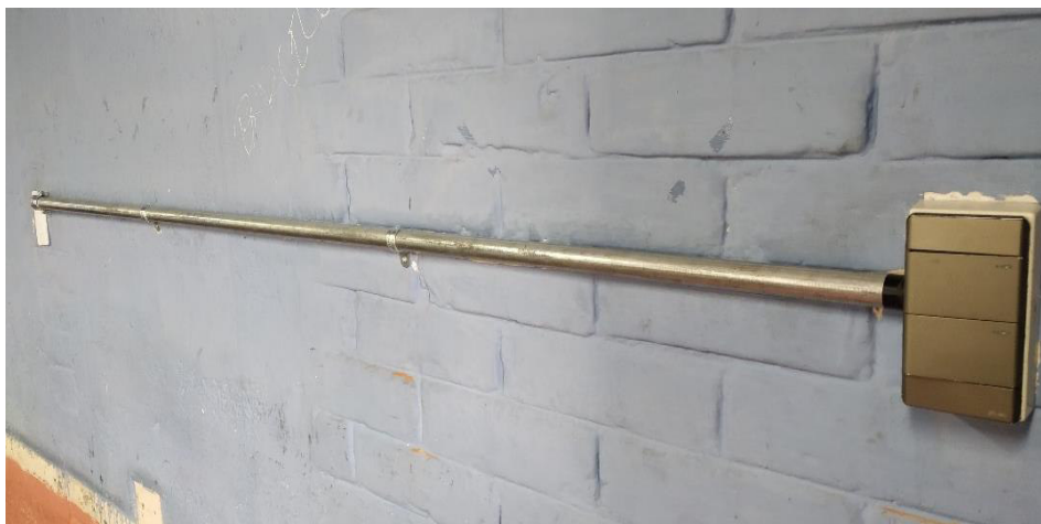
Figura 3.19 Adecuación de interruptor en aula 7 con canalización.
