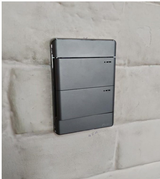
Figura 3.27 Acabado de interruptor doble para el circuito de iluminación.
