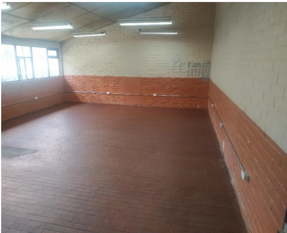
Figura 3.25 Circuito de tomacorrientes terminado en el aula 8.
