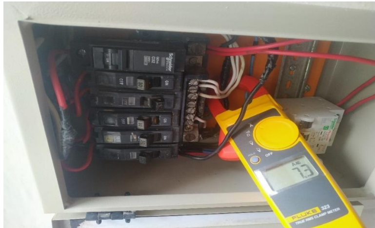
Figura 3.42 Prueba de carga a circuitos de iluminación.
