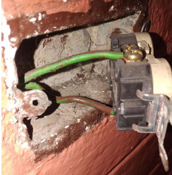
Figura 3.5 Incumplimiento de código de colores y falta de conductor de tierra.
