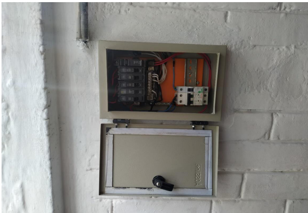
Figura 3.30 Instalación del tablero de distribución.
