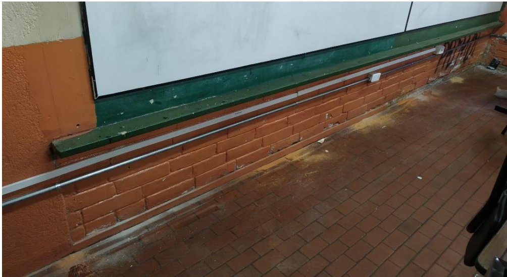
Figura 3.22 Reposicionamiento del punto de acceso ethernet en el aula 8.
