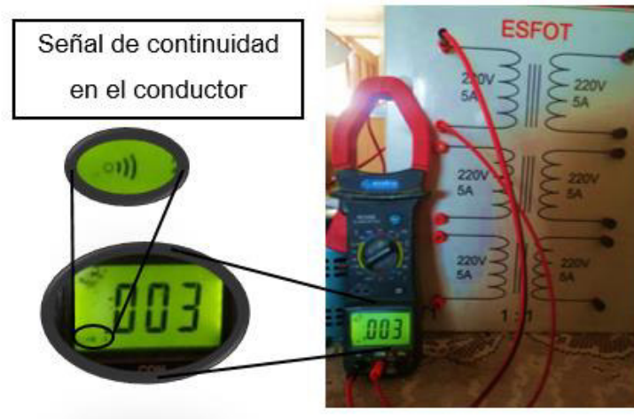
Figura 3.32 Prueba de continuidad.
