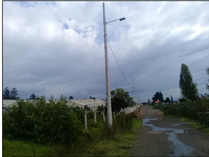
Figura 3.2 Postes eléctricos existentes.
