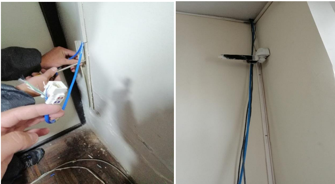
Figura 3.12 Instalación del cableado por la parte superior
