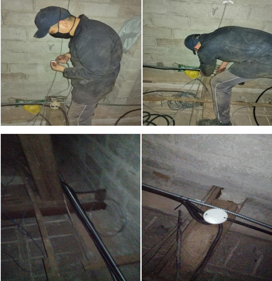
Figura 3.10 Implementación del cableado y del tubo PVC corrugado
