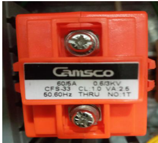
Figura 3.11 Transformador de corriente.
