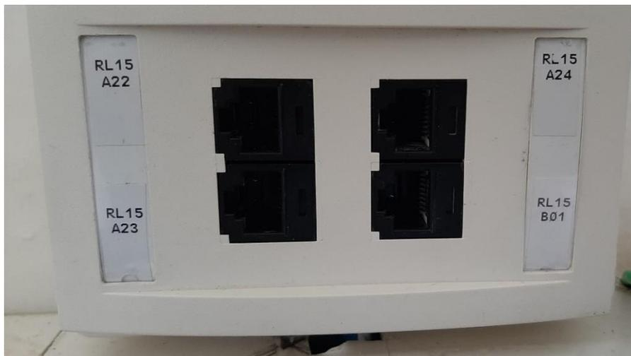
**Figura 3.37** Etiquetado puntos de red RL15.A22, RL15.A23, RL15.A24 y RL15.B01
