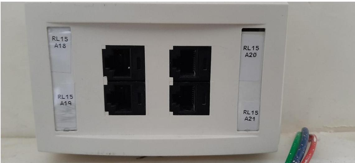
**Figura D20** Etiquetado de los puntos de red RL15.A18, RL15.A19, RL15.A20 y RL15.A21
