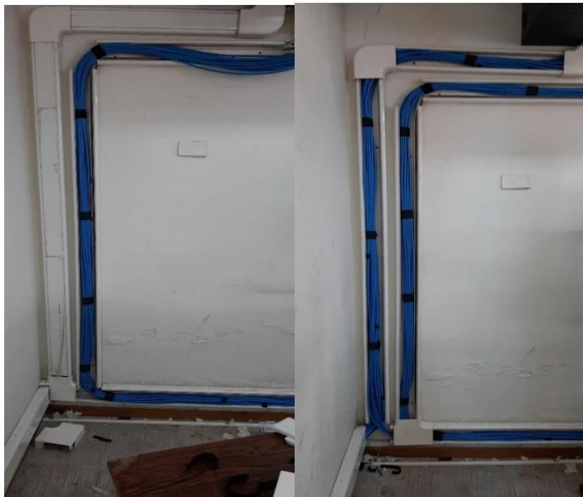
**Figura 3.24** Agrupación del cableado en canaletas mediante el uso de cinta velcro
