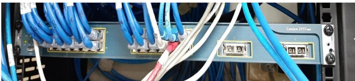
**Figura 3.14** Switch Cisco *Catalyst* 2950 antes de la implementación
