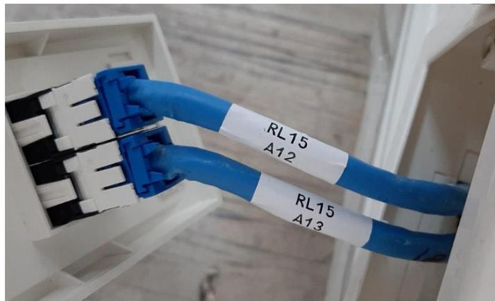
**Figura 3.35** Etiquetado de cables para los puntos de red RL15.A12 y RL15.A13
