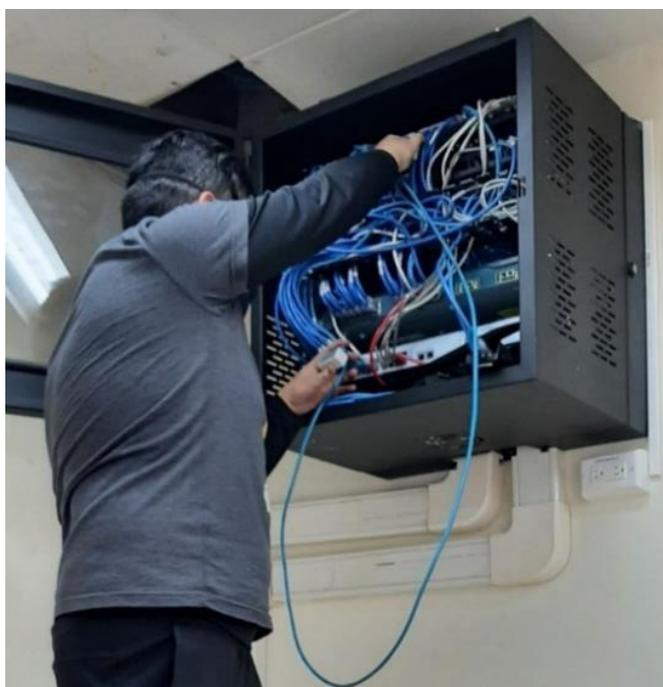
**Figura 3.8** Verificación del funcionamiento del cableado horizontal en el *rack*
