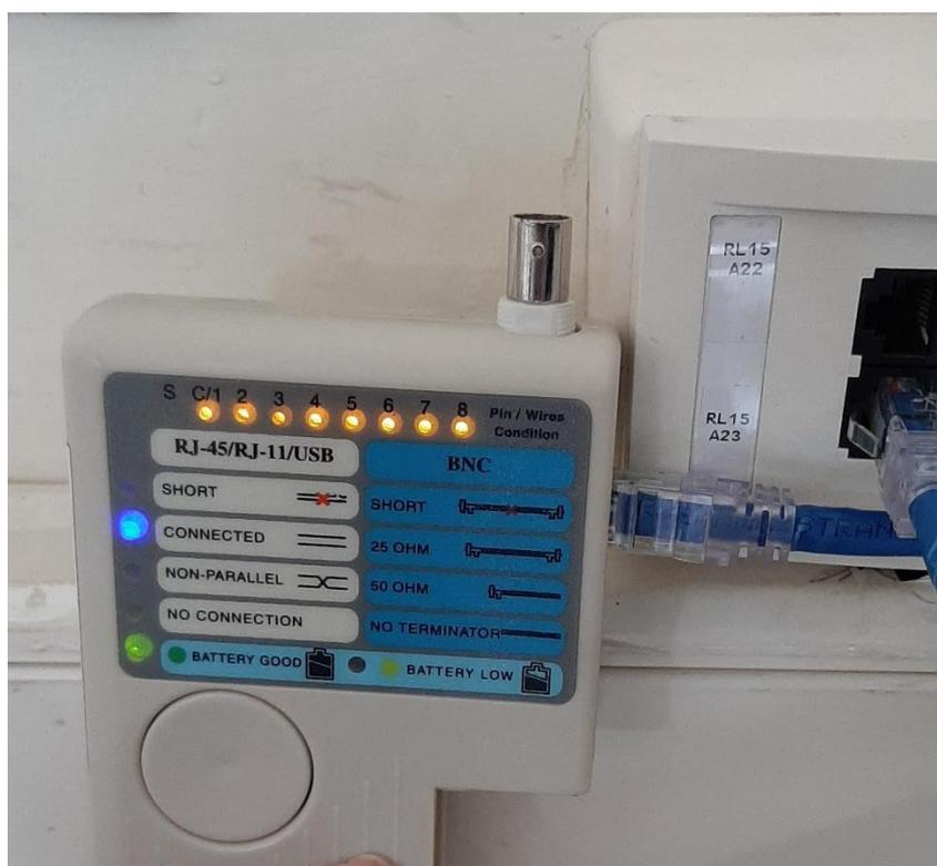
**Figura D14** Prueba de funcionamiento punto de red RL15.A23
