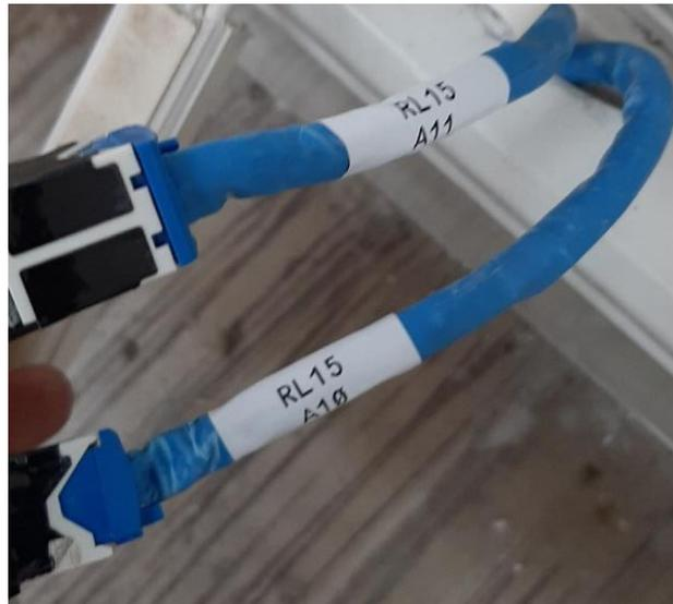
**Figura 3.34** Etiquetado de cables para los puntos de red RL15.A10 y RL15.A11
