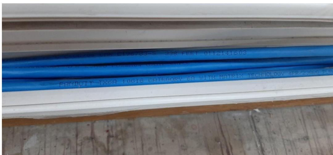
**Figura 3.6** Cableado categoría 6A 23 AWG Panduit existente en el laboratorio 15
