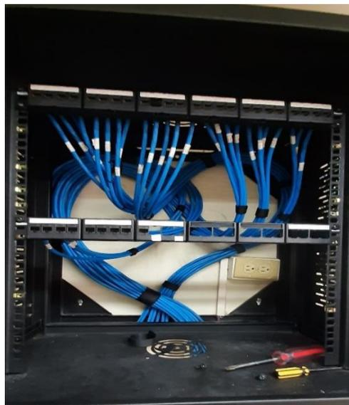
**Figura 3.39** Ordenamiento y etiquetado de los cables dentro del *rack*
