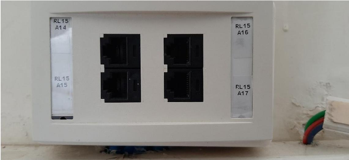
**Figura D19** Etiquetado de los puntos de red RL15.A14, RL15.A15, RL15.A16 y RL15.A17
