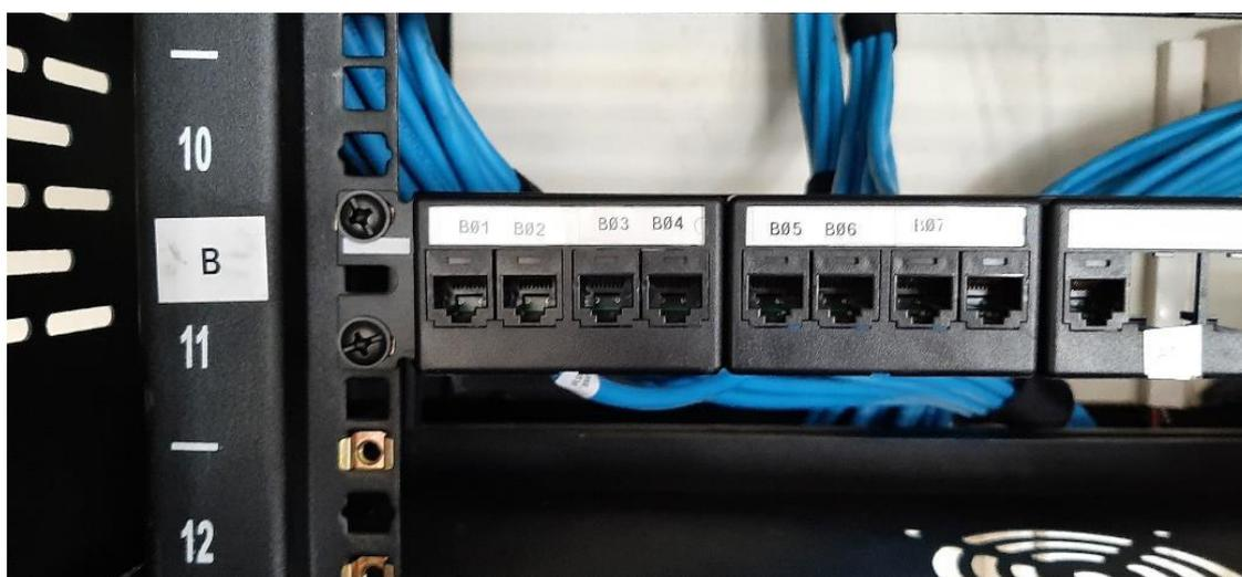
**Figura 3.41** Etiquetado *patch panel B*
