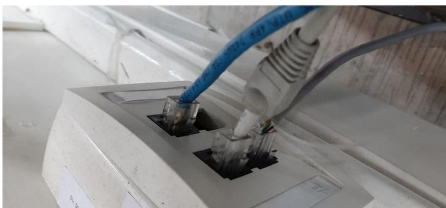
**Figura 3.5** Patch cords conectados a los puntos de red
