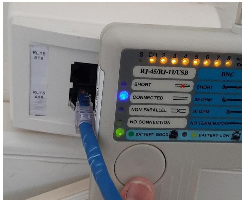
**Figura D10** Prueba de funcionamiento punto de red RL15.A19
