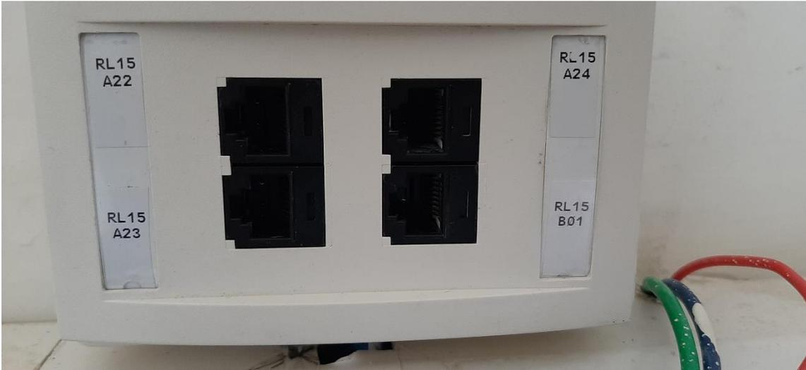
**Figura D21** Etiquetado de los puntos de red RL15.A22, RL15.A23, RL15.A24 y RL15.B01
