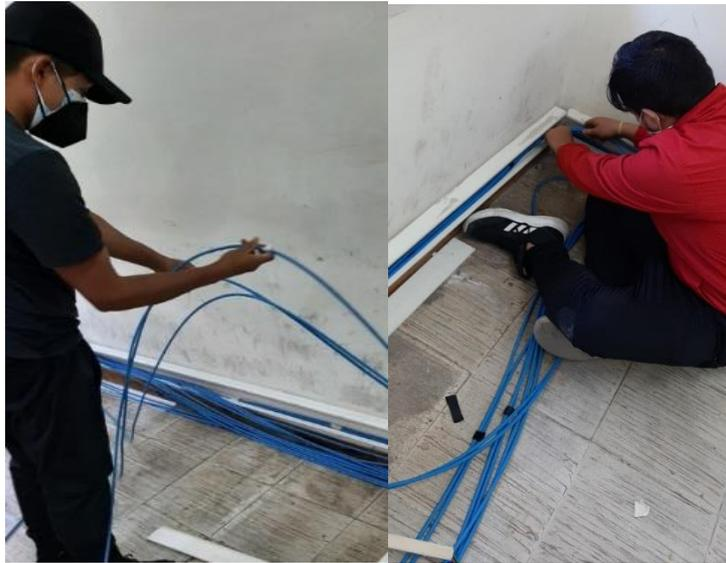
**Figura 3.23** Tendido de cable del SCE del laboratorio 15 mediante canaletas
