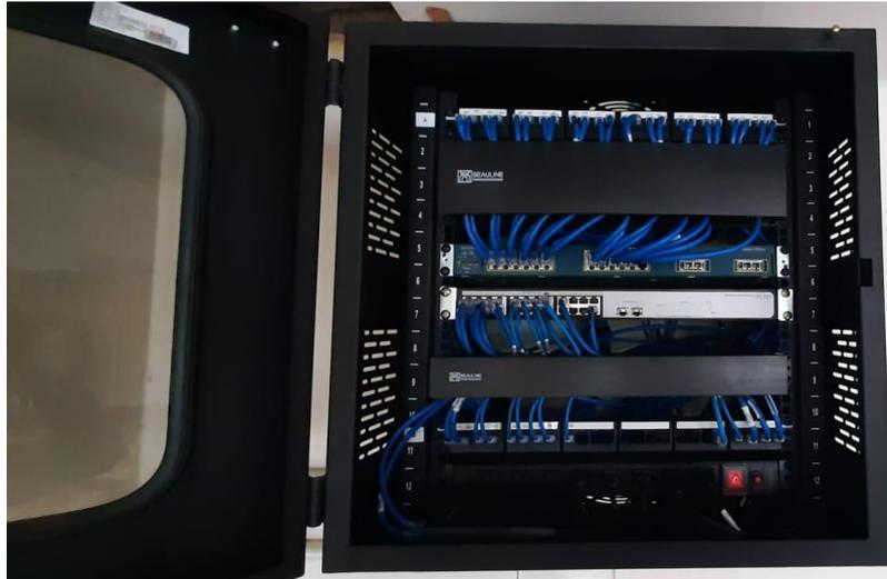
**Figura 3.42** Organización realizada para el *rack* del laboratorio 15
