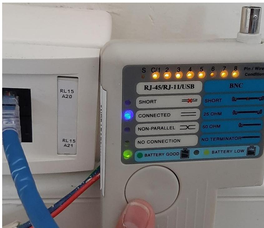
Figura D11 Prueba de funcionamiento punto de red RL15.A20
