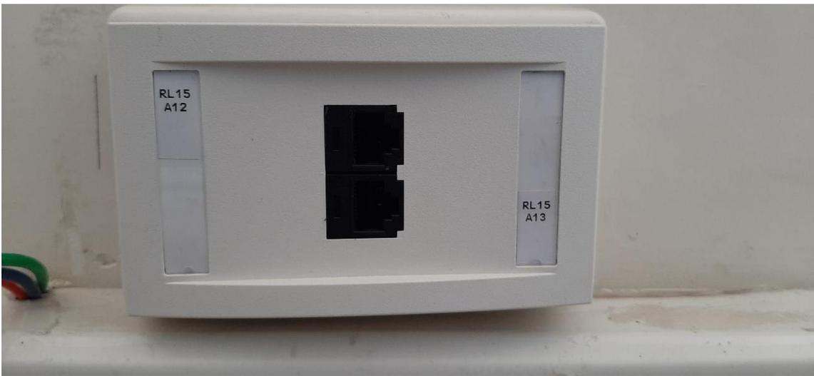
**Figura D18** Etiquetado de los puntos de red RL15.A12 y RL15.A13
