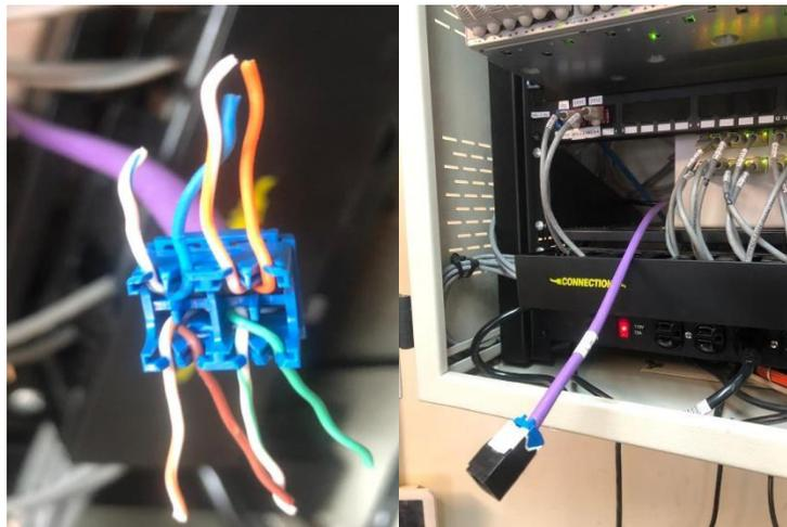
**Figura 3.45** Ponchado del *jack* RJ45 del enlace de *backbone*
