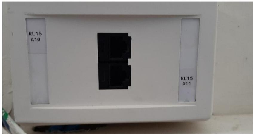
**Figura 3.36** Etiquetado de los puntos de red RL15.A10 y RL15.A11
