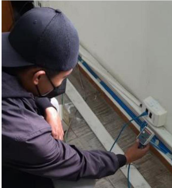
**Figura 3.9** Verificación del funcionamiento del cableado horizontal
