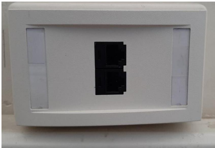
**Figura 3.29** Instalación de puntos de red dobles desde RL15.A10 a RL15.A13
