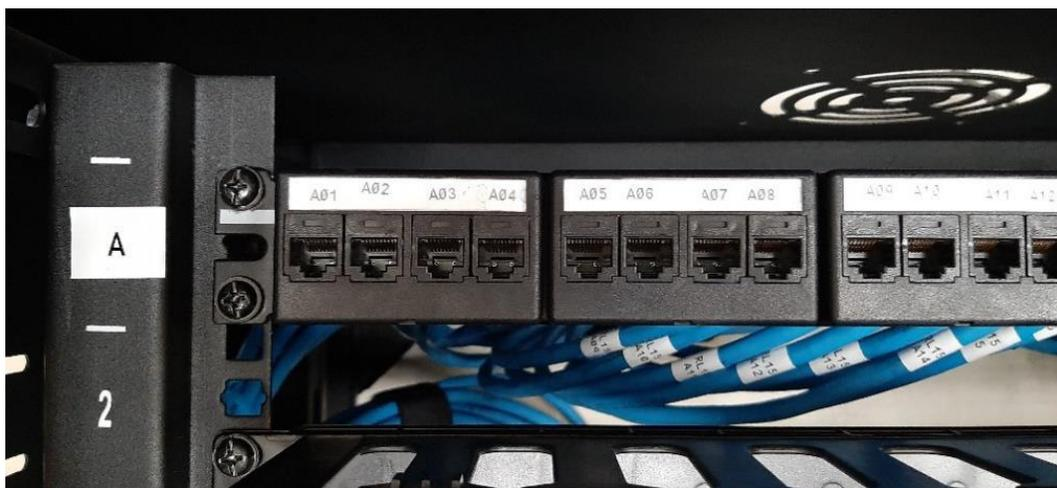
**Figura 3.40** Etiquetado *patch panel A*
