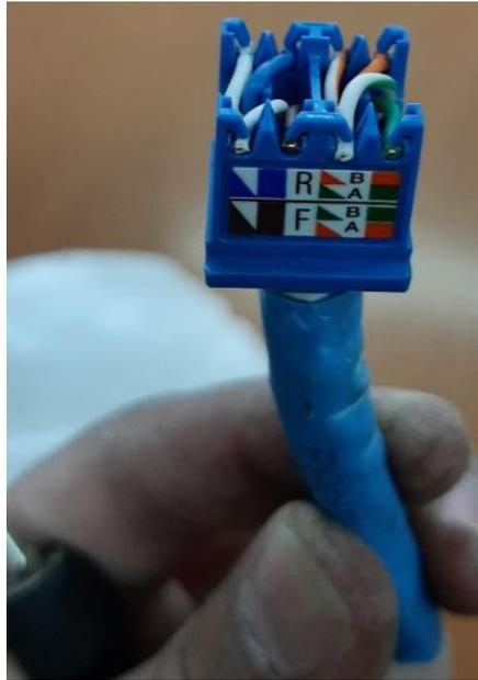
**Figura 3.27** Estado del *jack* luego de retirar el exceso de cable
