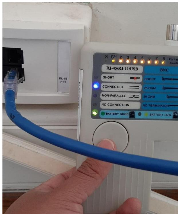
**Figura D2** Prueba de funcionamiento punto de red RL15.A11
