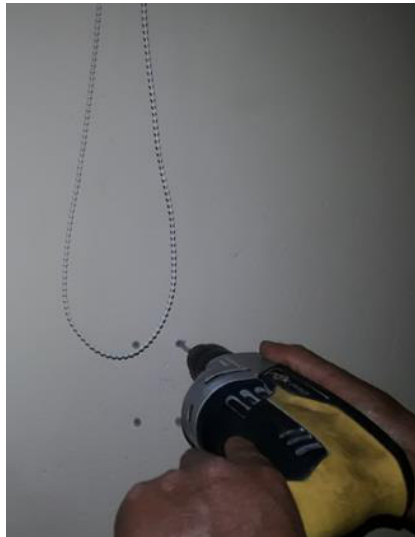
Figura 3.305 Perforación de la pared para colocar los soportes del motor
