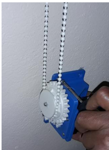
Figura 3.306 Colocación del sistema de las cortinas
