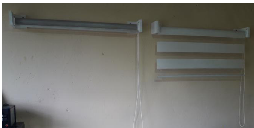
Figura 3.304 Instalación de las persianas enrollables
