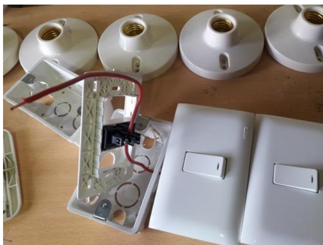
Figura 3.314 Ubicación de los interruptores sobre las cajas
