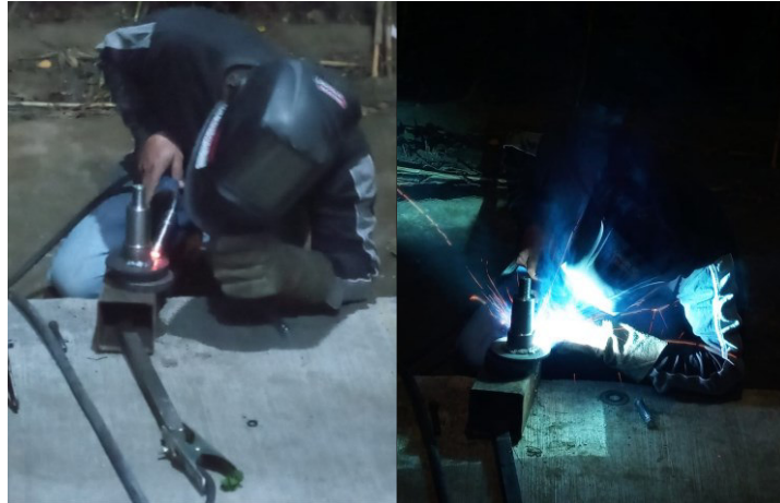
Figura 2.44 .Soldadura de placa a eje principal. Fuente: Propia
