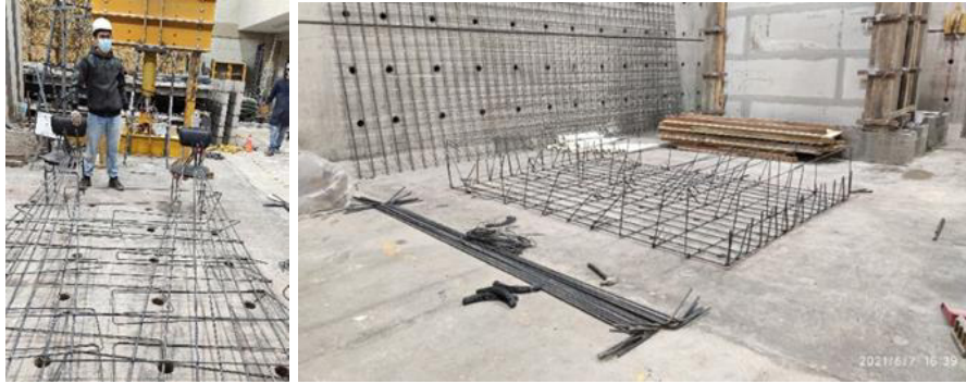
Figura 92. Proceso de construcción armadura de acero de refuerzo.
