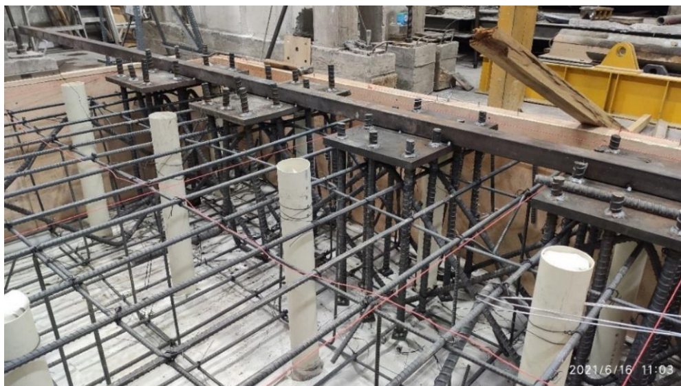
Figura 97. Instalación placa base y anclajes de prototipo.
