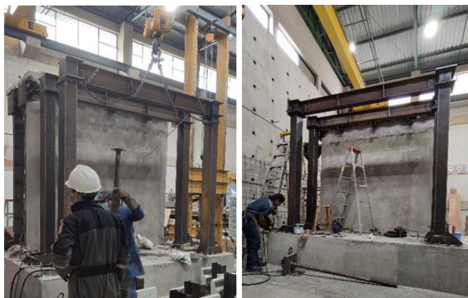
Figura 106. Implantación de pórtico en losa de cimentación.
