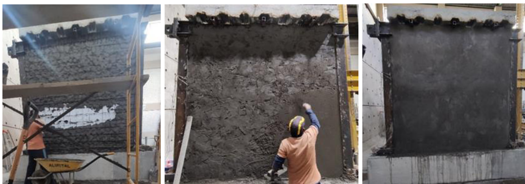
Figura 119. Reforzamiento para pórtico 2 (reforzado con daño en la mampostería).
