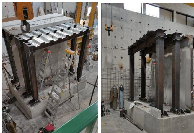
Figura 107. Pórticos con planchas deck colocadas.
