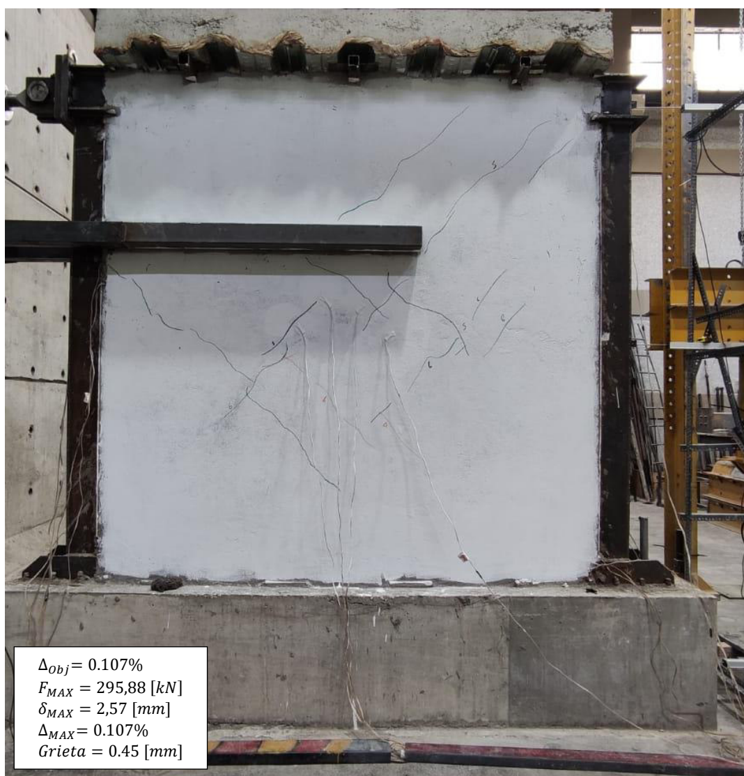
Figura 135. Imagen al final de “Daño Leve”.
