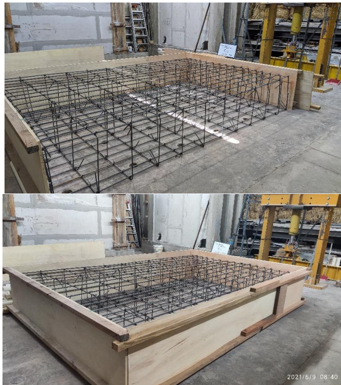
Figura 93. Colocación de encofrado.
