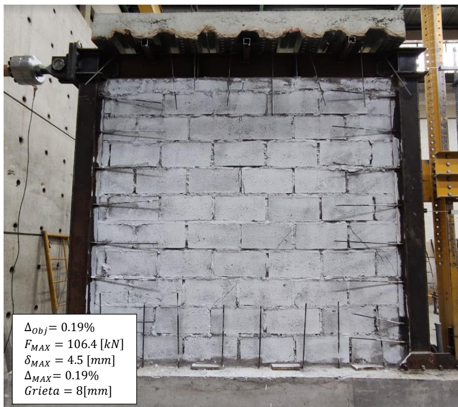
Figura 122. Etapa “Daño Leve” de pórtico con panel de relleno.
