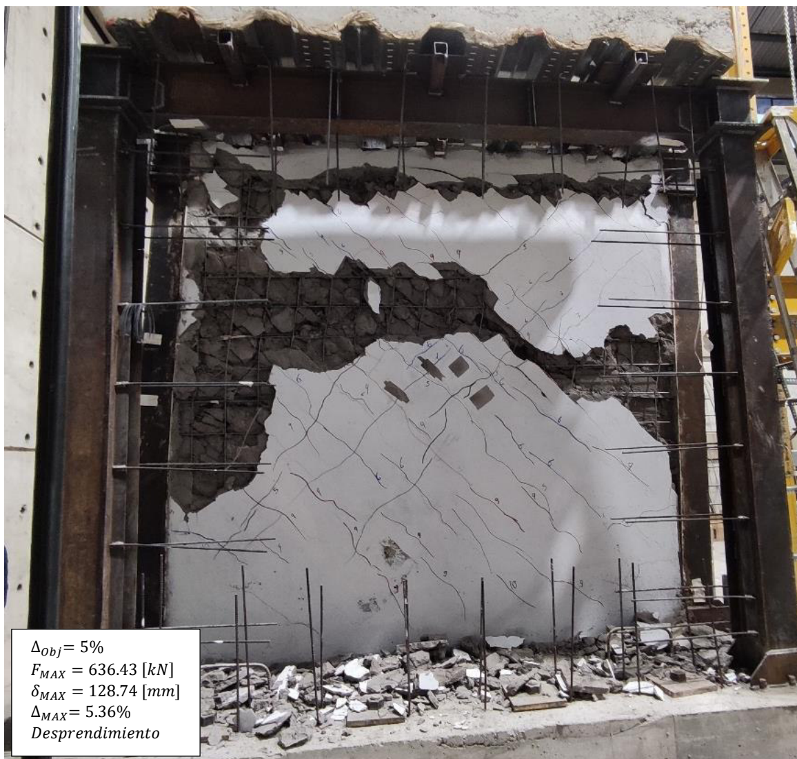
Figura 133. Imagen al final de "Daño Completo"
