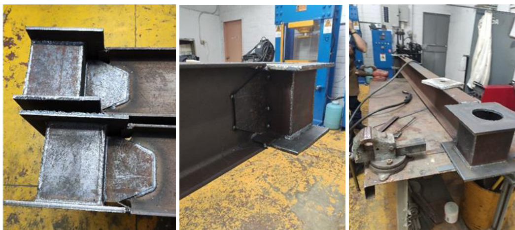
Figura 104. Soldadura conexión viga-columna y viga.
