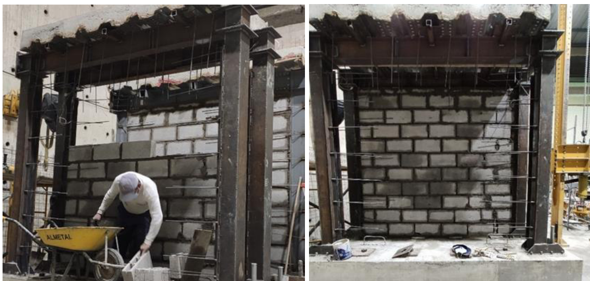
Figura 110. Construcción de pared para pórtico 1 (reforzado sin afectar la mampostería).
