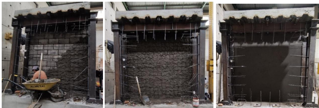
Figura 118. Reforzamiento para pórtico 1 (reforzado sin afectar la mampostería).
