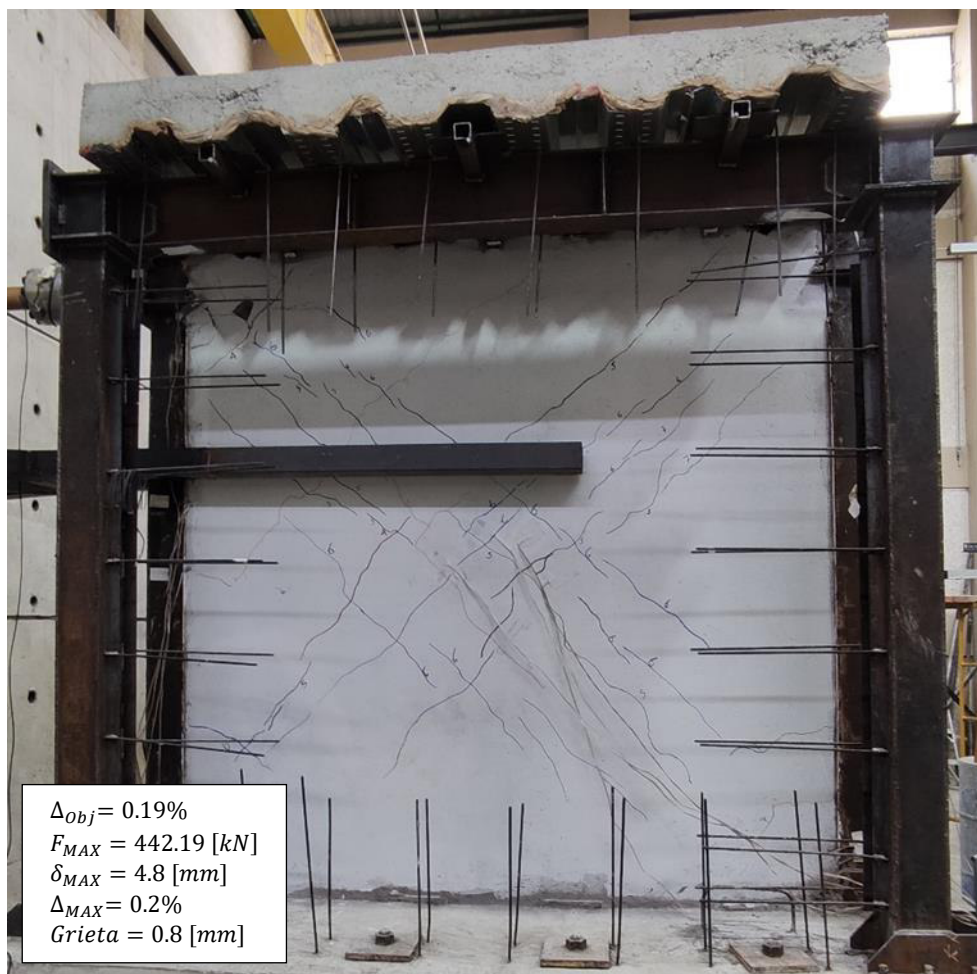
Figura 129. Imagen al final de "Daño Moderado"
