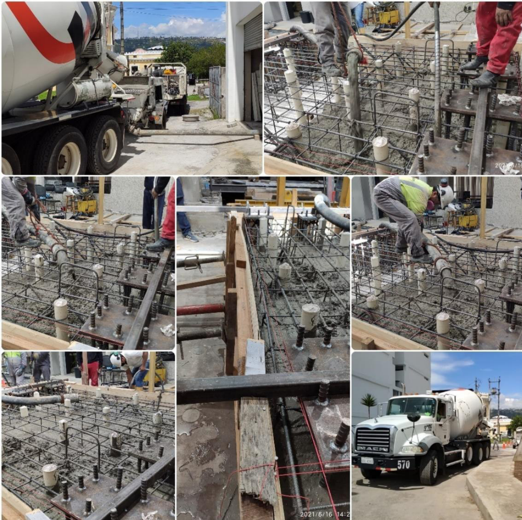
Figura 98. Hormigonado de losa de cimentación.
