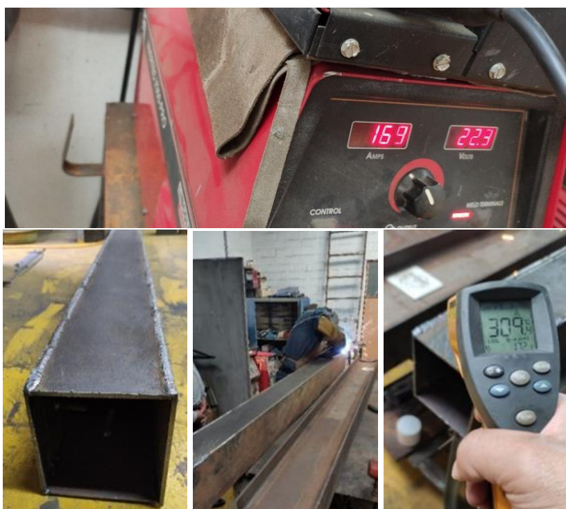
Figura 102. Soldadura de placas de columna en tramos y sus máximos de temperatura, amperaje y voltaje.
