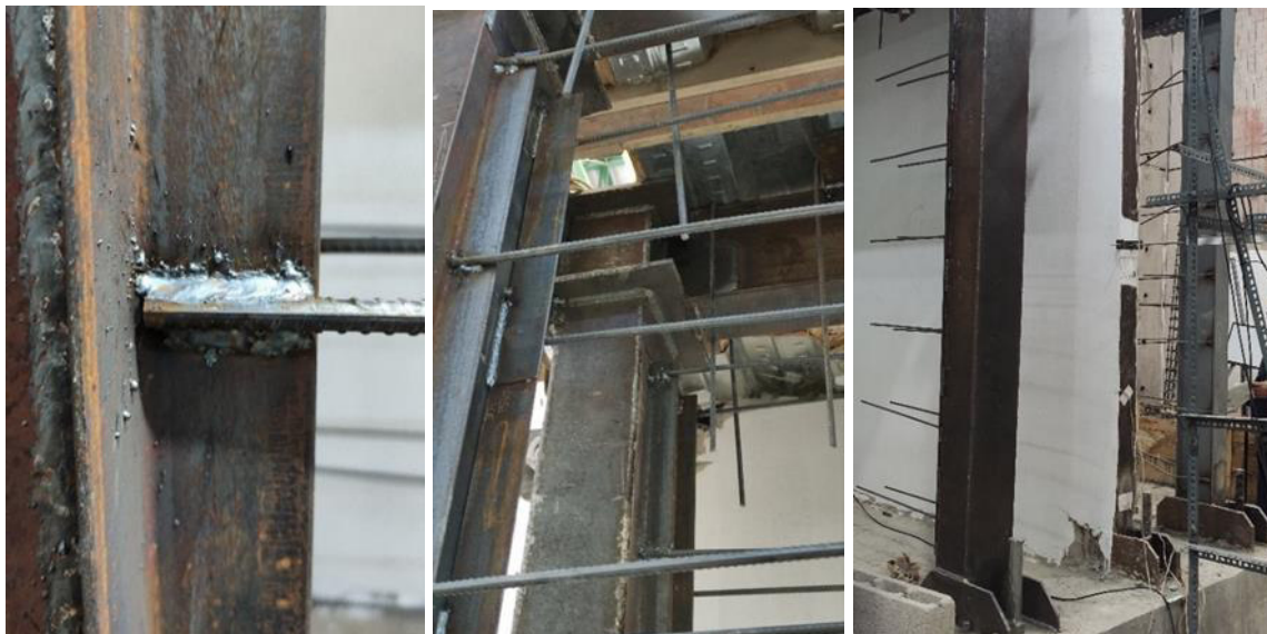
Figura 112. Soldadura de ángulos y chicotes para conexión de malla electrosoldada a las columnas.
