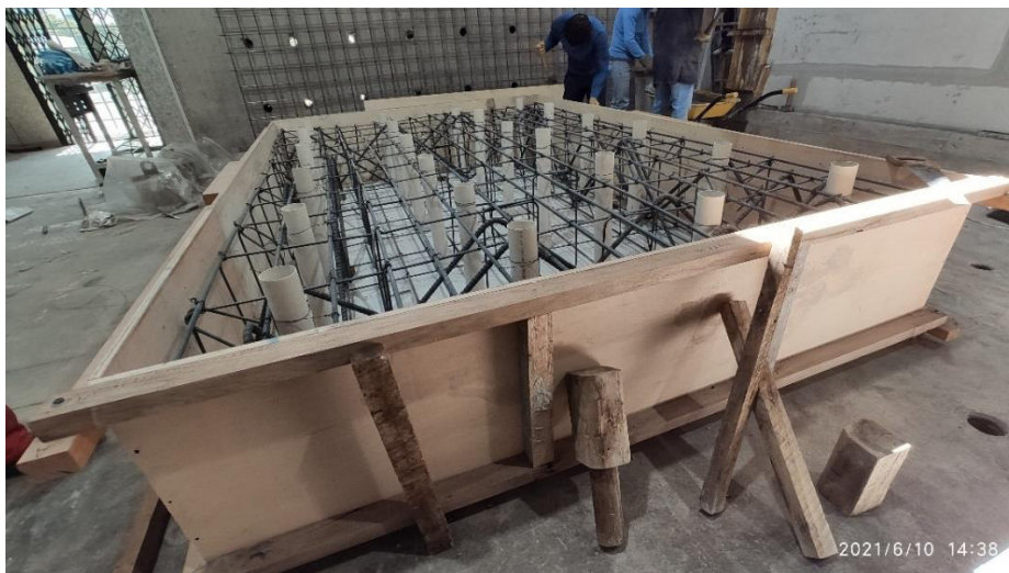
Figura 94. colocación tubería PVC" ejes de anclaje CIV.
