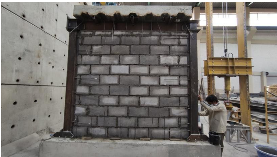
Figura 111. Construcción de pared para pórtico 2 (reforzado con daños en mampostería).
