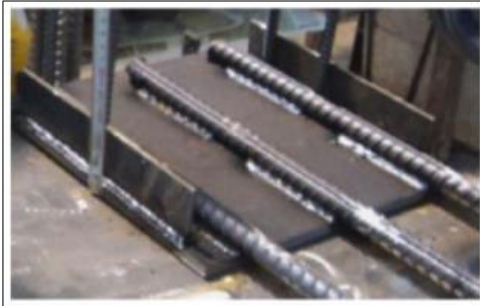
Figura 9. Soldadura entre las barras de acero y placa.
