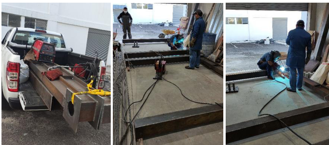
Figura 105. Traslado al CIV y unión de sección viga-conexión con pórtico.
