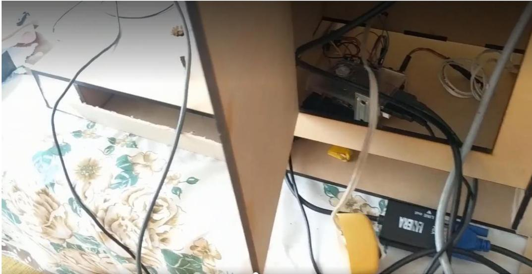
**Figura 3.33** Cableado posterior sin recoger y componentes sin sujeción
