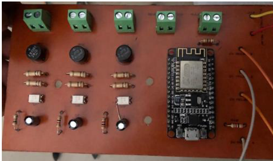
Figura 3.62 Fabricación y soldado del circuito domótico de la parte superior
