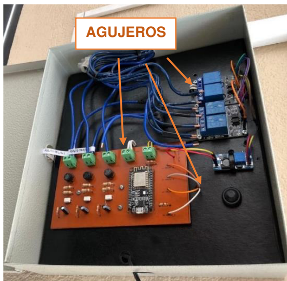
Figura 3.72 Base flotante en el cajetín metálico
