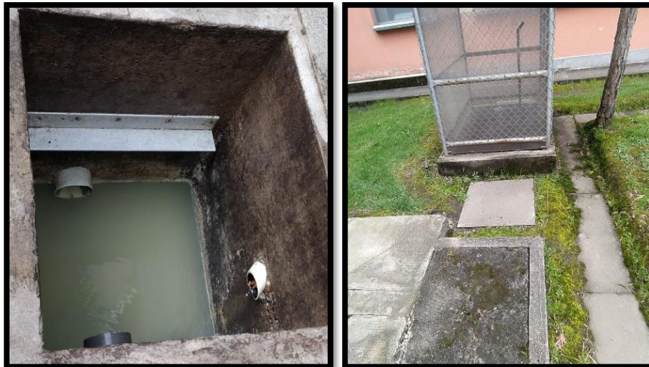
Figura 14. Muestreo en la pre-trampa de grasas
