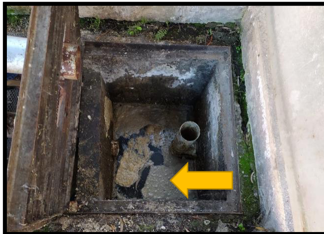
Figura 16. Muestreo en la trampa de grasas principal
