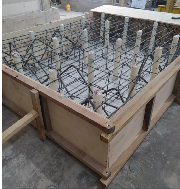
Figura 66. Colocación de guías para ejes de anclaje y encofrado de cimentación.
