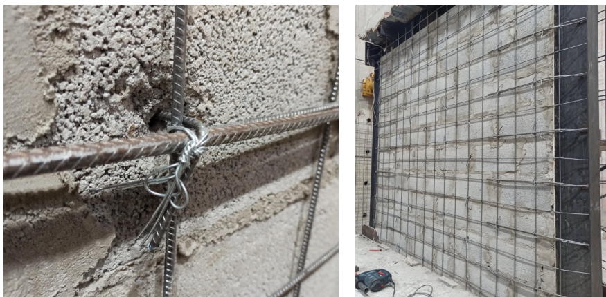
Figura 78. Colocación grapas y de malla electrosoldada.
