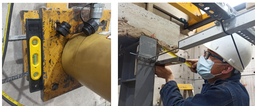
Figura 75. Instrumentación del prototipo, colocación de gato y deformímetros.
