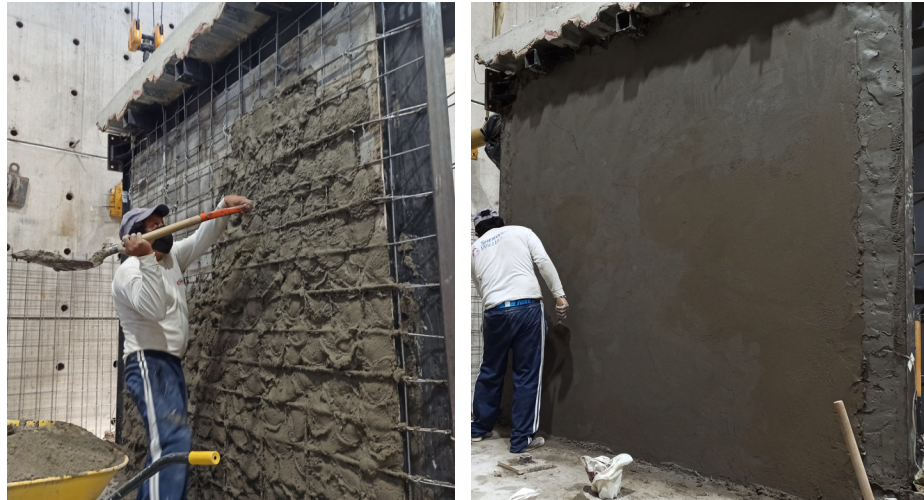
Figura 80. Champeado y paletado de enlucido de baja resistencia.
