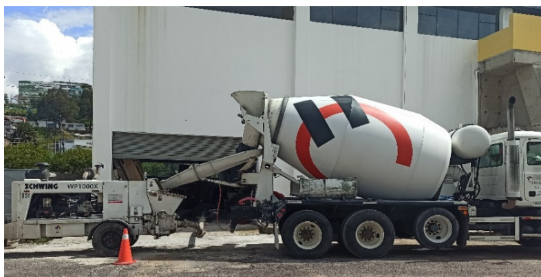
Figura 19. Hormigón premezclado Holcim, utilizado en la cimentación.
