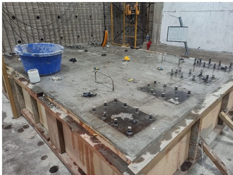
Figura 69. Hidratación de la losa de cimentación.
