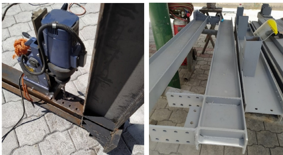
Figura 70. Perforación para conexión viga-columna/columnas y vigas de prototipos.
