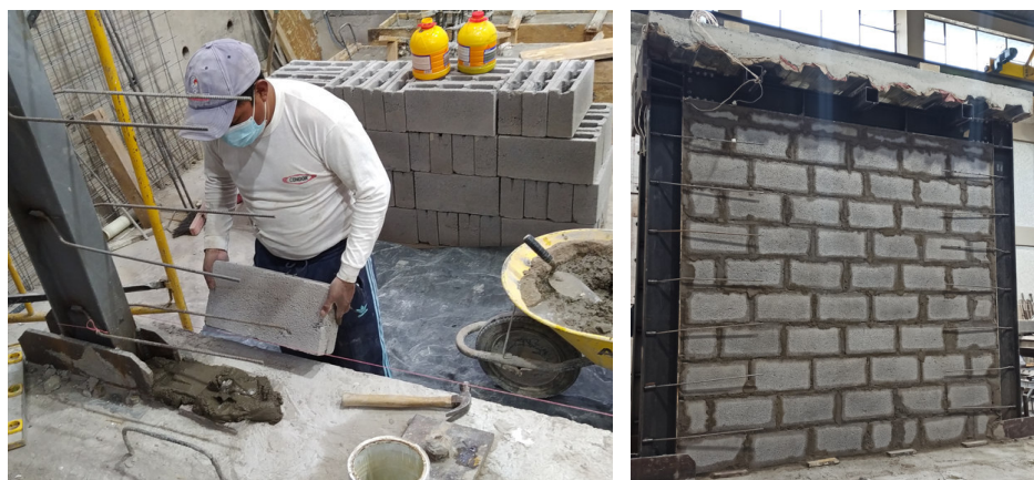
Figura 77. Colocación de mampostería de bloque hueco de hormigón.
