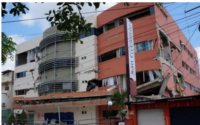
Figura 14. Colapso de rellenos de mampostería de edificios afectados por el Sismo del 16A en la ciudad de Portoviejo.
