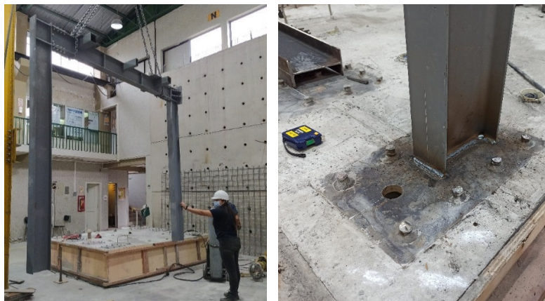
Figura 71. Izado de pórtico y soldadura de columna con placa base.
