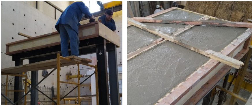
Figura 73. Fundición de loseta.
