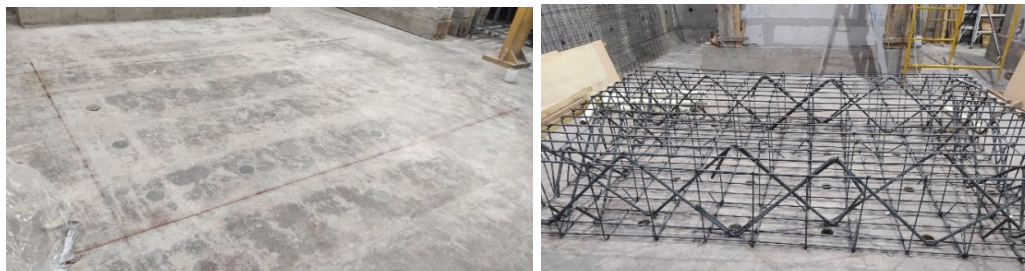
Figura 65. Timbrado y armado longitudinal y transversal de hierros para cimentación.
