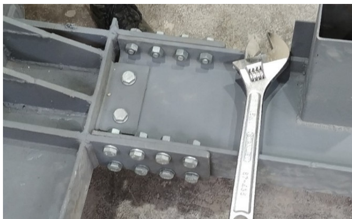
Figura 24. Pernos ASTM A325 para conexión viga-columna.
