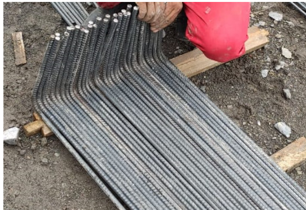
Figura 18. Acero de refuerzo utilizado en el proyecto.
