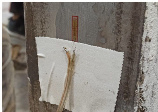
Figura 38. Strain gauge colocado en la base de la columna de acero.
