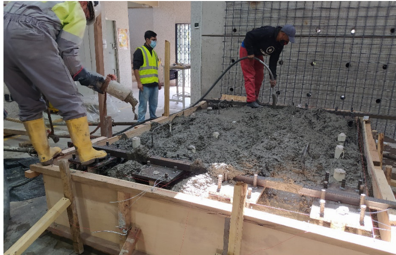
Figura 68. Vertido y vibrado del hormigón de cimentación.
