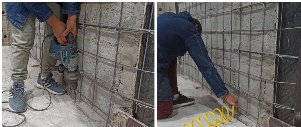
Figura 79. Actividades previas a la colocación de chicotes en cimentación.
