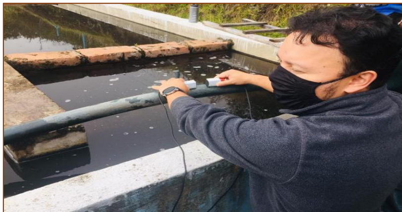
Anexo 5.2.- Medición de las tuberías con sensor ultrasónico y del tanque de almacenamiento con flexómetro.
