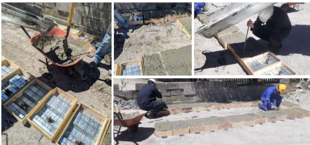
Figura 40. Hormigonado de losas Elaborado: Valenzuela & Velasco
