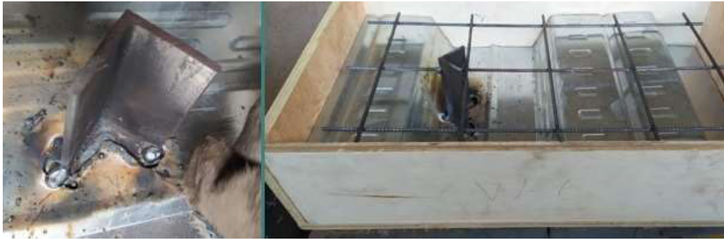
Figura 33. Ubicación de malla electrosoldada
