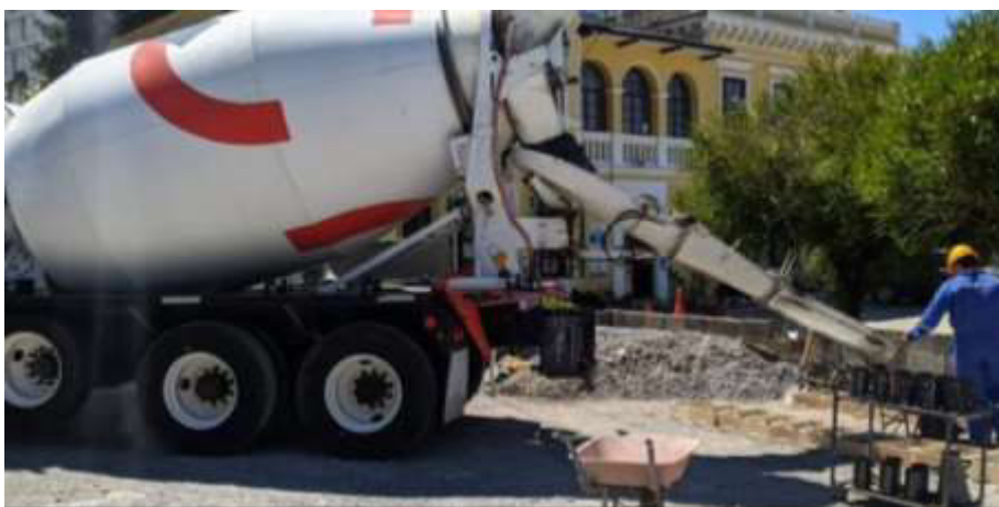
Figura 37. Entrega de hormigón premezclado
