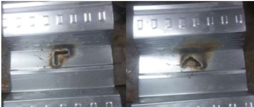
Figura 32. Perforado en lámina deck
