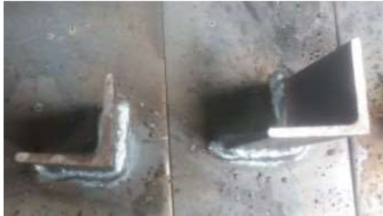
Figura 31. Soldadura de conectores
