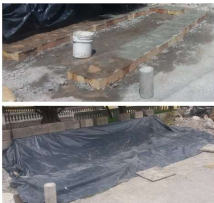
Figura 41. Curado de losas Elaborado: Valenzuela & Velasco
