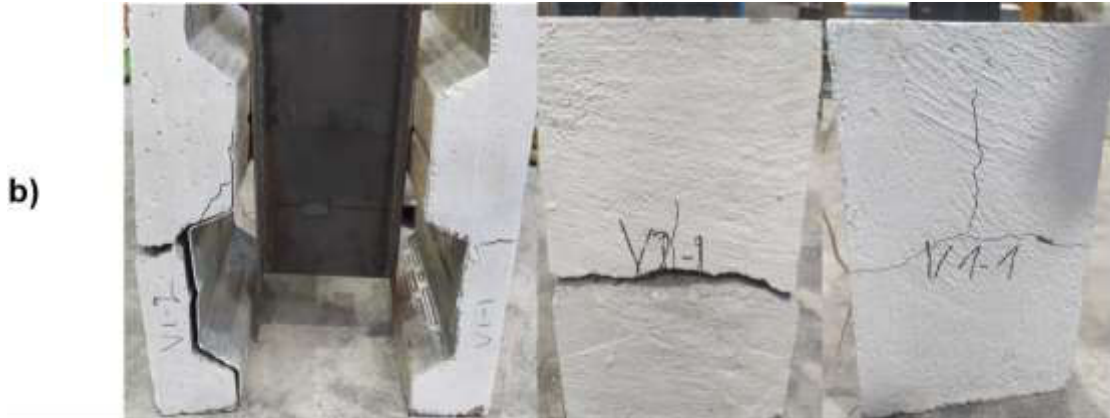
Figura 43. Falla en las losas de hormigón.
