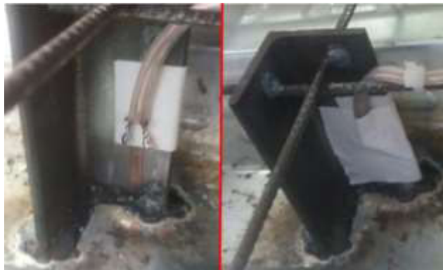
Figura 35. Instalación de strain gauges
