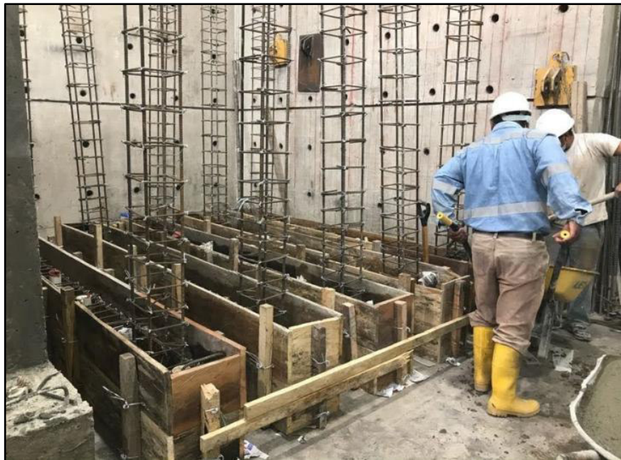
Figura 3.46. Hormigonado y vibrado en las Vigas de Cimentación
