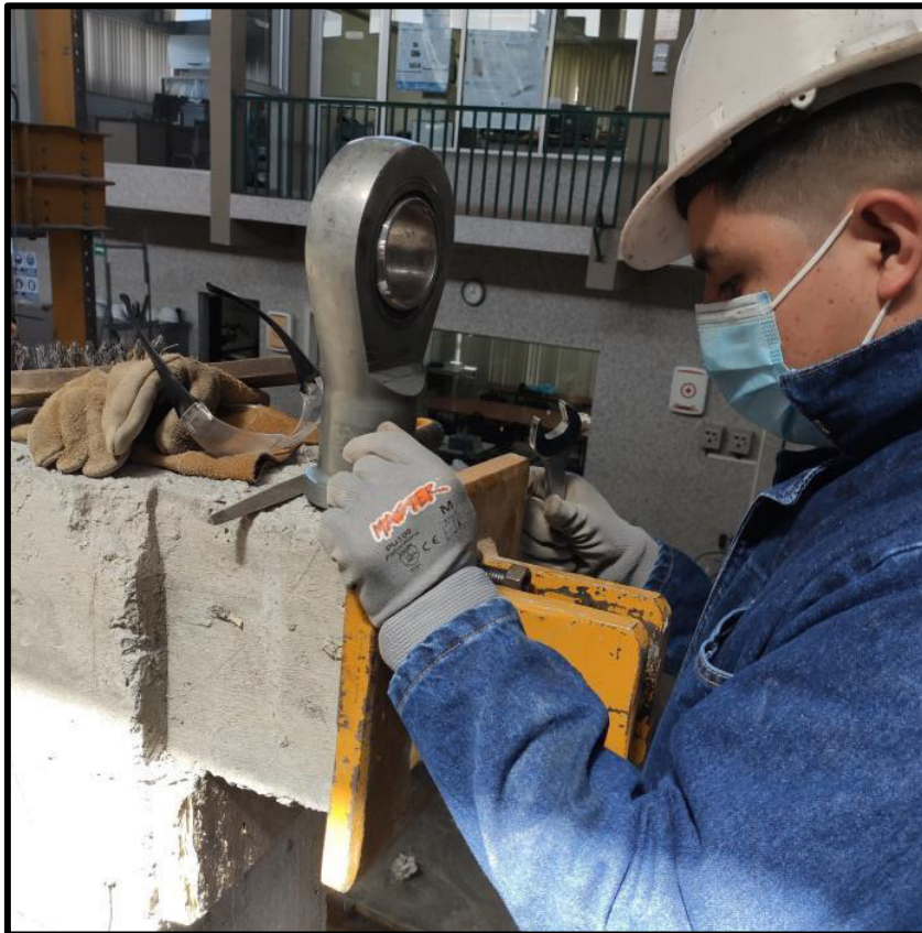
Foto 1. Montaje de la placa hembra mediante 4 pernos embebidos en los Muros
