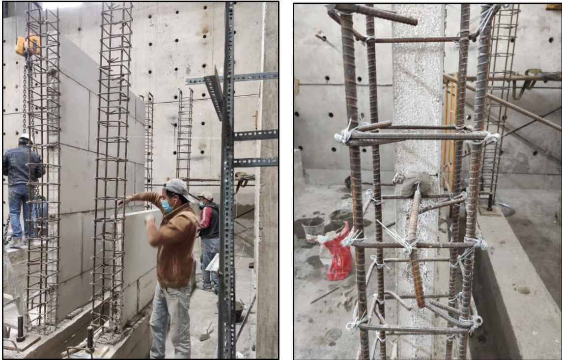
Figura 3.53. Instalación de los paneles del MMCR
