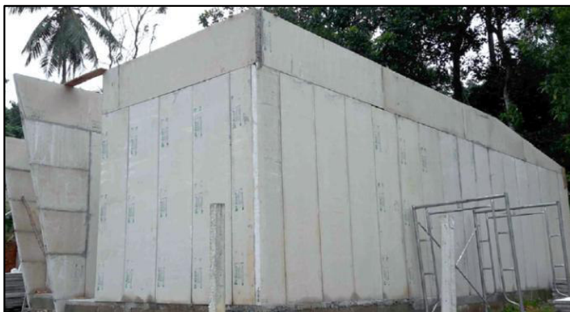
Figura 2.5. Aplicación de los paneles de fibrocemento con hormigón alivianado con EPS en una casa de una sola planta
