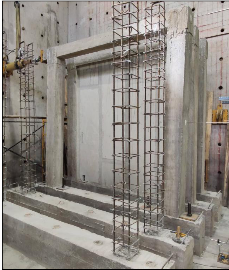
Figura 4.6. Pórtico antes del ensayo
