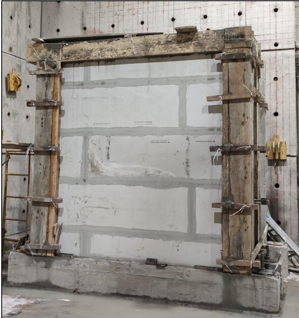
Figura 3.56. Encofrado y fundido de los elementos confinantes
