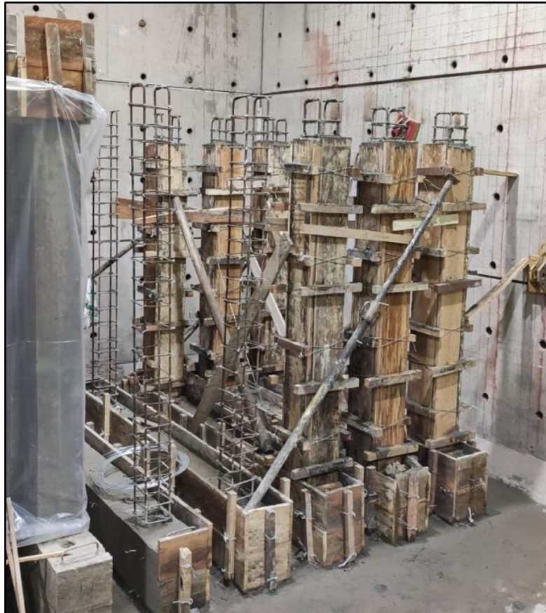
Figura 3.48. Hormigonado de columnas del MMS y Pórtico
