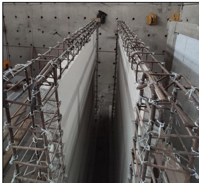
Figura 3.55. Colocación y verificación del nivel de las vigas de confinamiento
