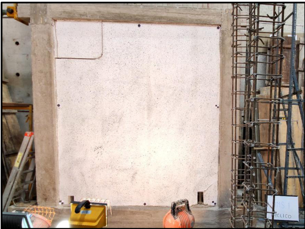
Foto 23. Fisuras Ciclo 38 en el MMS 1 (Halado ←), \Delta=-29.76\text{mm} ; P=-137.08\text{kN}
