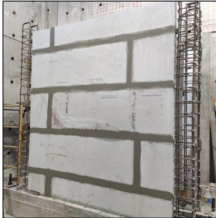
Figura 3.54. Colocación de la cinta de fibra de vidrio
