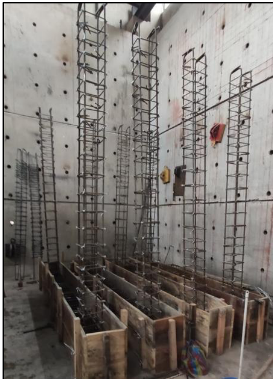
Figura 3.45. Colocación del encofrado en las Vigas de Cimentación
