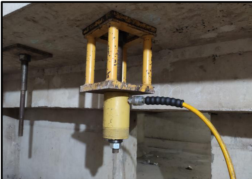
Foto 5. Montaje del gato hidráulico con el banco de pretensado
