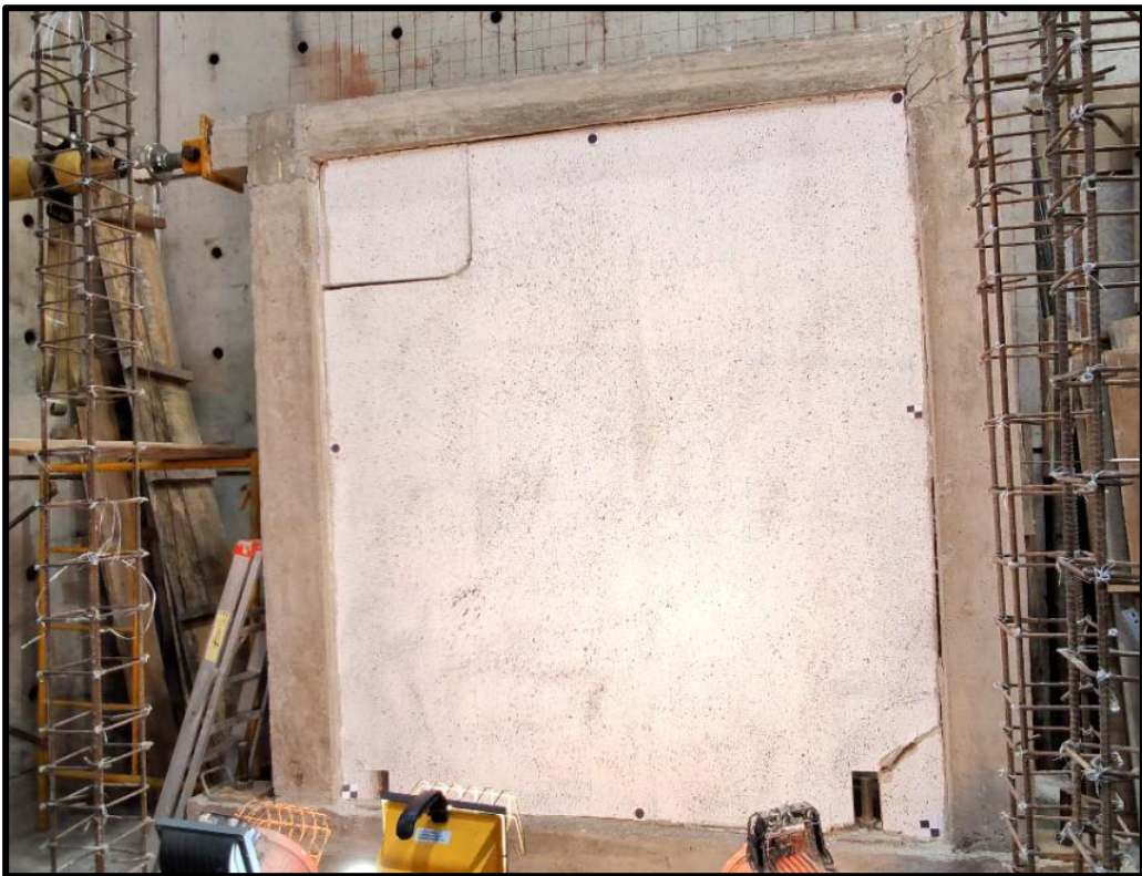
Foto 27. Fisuras Ciclo 47 en el MMS 1 (Halado ←), \Delta=-59.26\text{mm} ; P=-109.68\text{kN}
