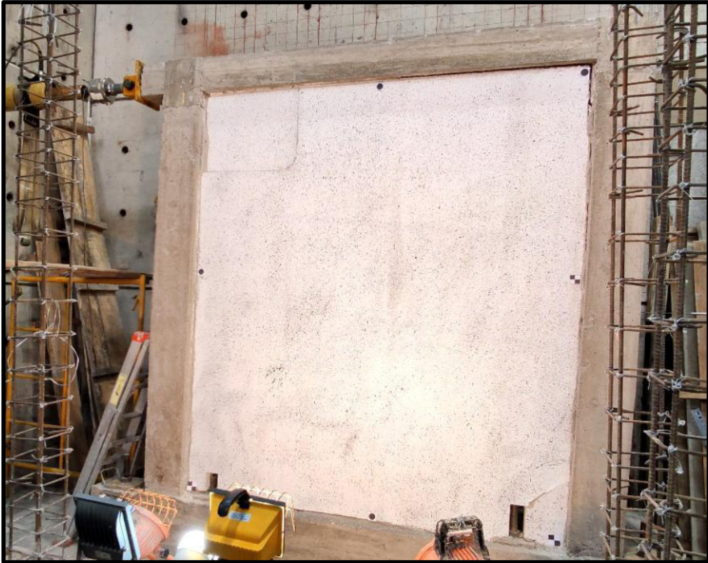
Foto 26. Fisuras Ciclo 47 en el MMS 1 (Empuje →), \Delta=60.00\text{mm} ; P=103.40\text{kN}
