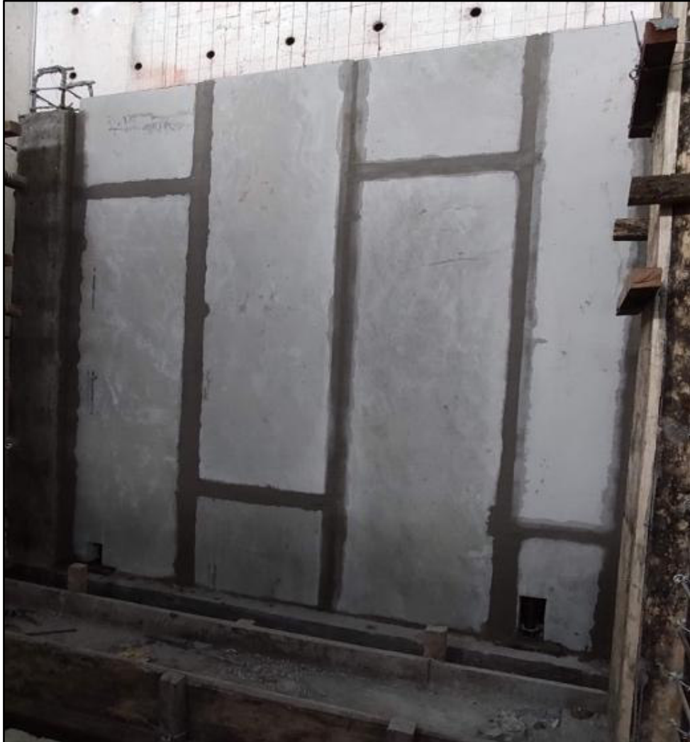
Figura 3.50. Colocación de la cinta de fibra de vidrio.
