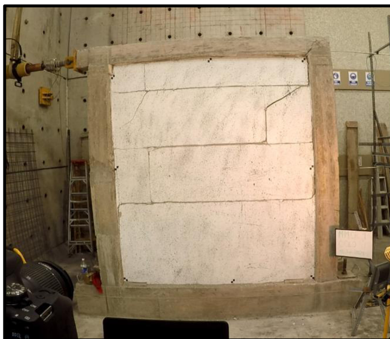
Foto 47. Fisuras Ciclo 10(41) en el MMCR 1(Halado \leftarrow ), \Delta=-39.64\text{mm} ; P=-87.82\text{kN}
