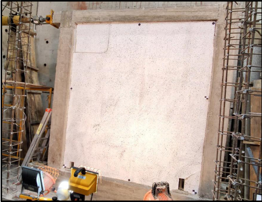
Foto 24. Fisuras Ciclo 41 en el MMS 1 (Empuje →), \Delta=38.00\text{mm} ; P=121.77\text{kN}
