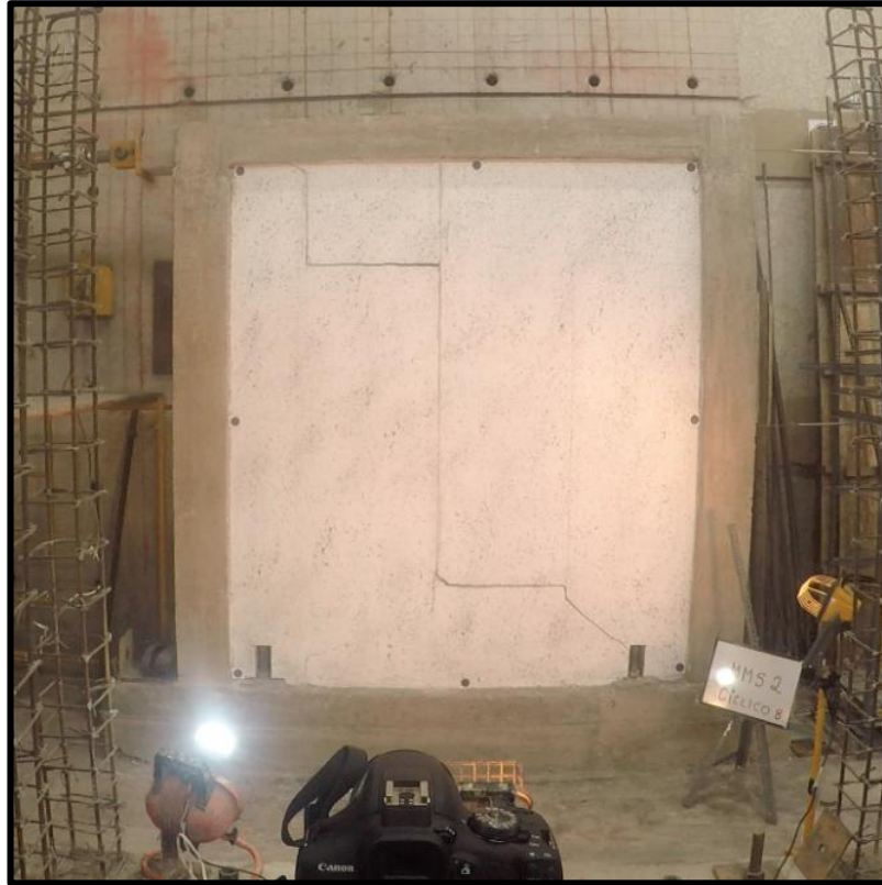
Foto 36. Fisuras Ciclo 8(35) en el MMS 2(Empuje →), \Delta=23.58\text{mm} ; P=93.44\text{kN}
