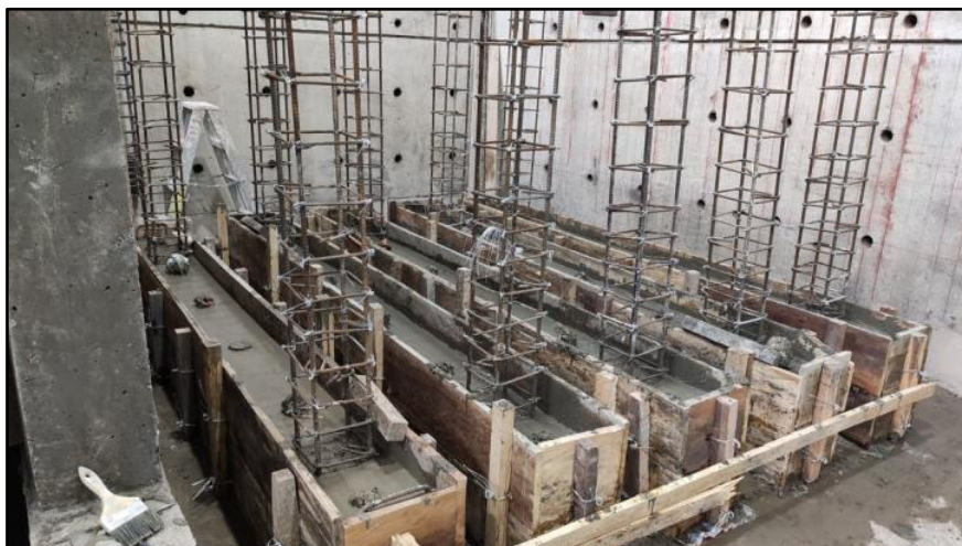
Figura 3.47. Vigas de cimentación fundidas
