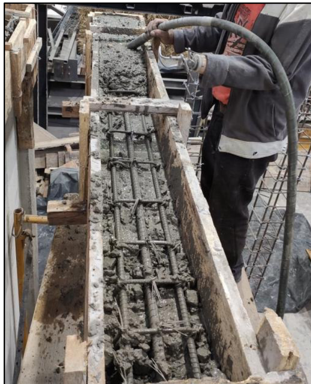
Figura 3.52. Hormigonado y Vibrado de las Vigas de Confinamiento
