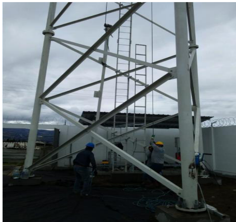
Figura 2. 1. Montaje Torre Autoportada Fuente: (Propia)
