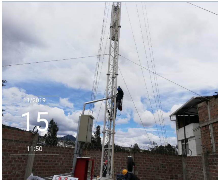
Figura 2. 2. Montaje Torre Atirantada Fuente: (Propia)
