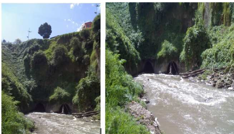
Foto 2.21 Visto a la entrada del túnel de encauzamiento de la Rodrigo de Chávez
