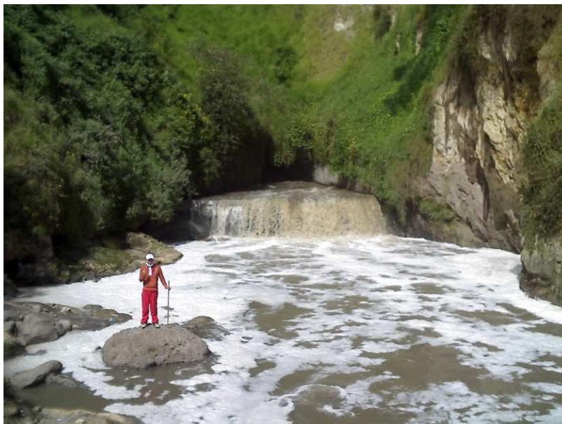
Foto 2.17 Embaulamiento Cumandá visto desde aguas abajo
