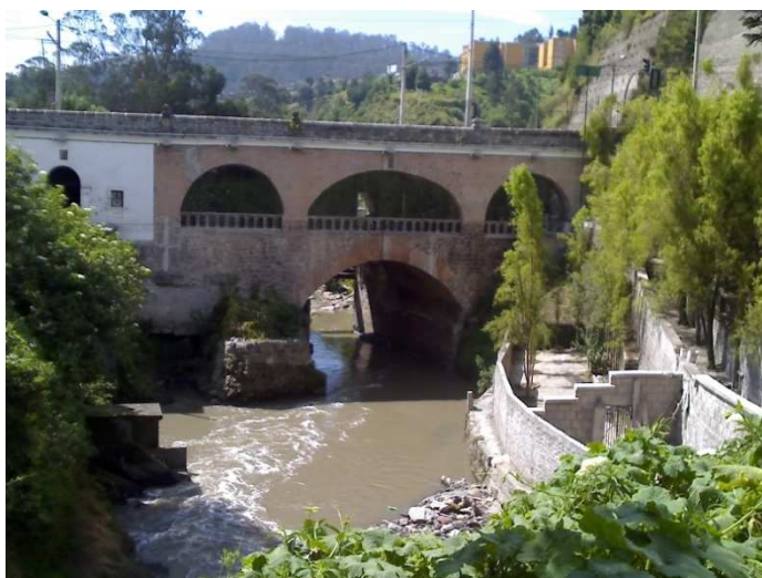
Foto 2.18 Puente La Recoleta visto desde aguas arriba
