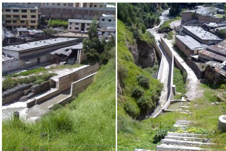
Foto 2.22 Vista a la salida del túnel de encauzamiento de la Rodrigo de Chávez
