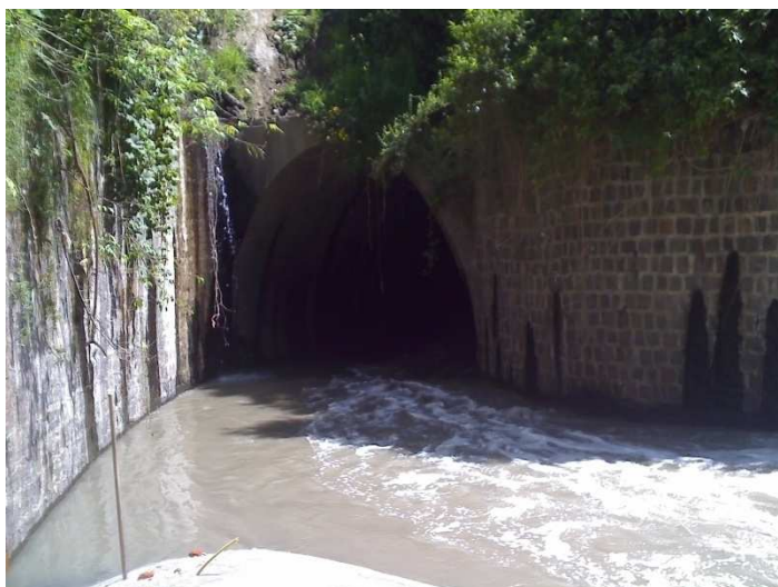
Foto 2.20 Embaulamiento Chimbacalle visto desde aguas arriba
