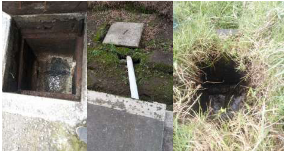
Figura 11. pozos de revisión y vertedero
