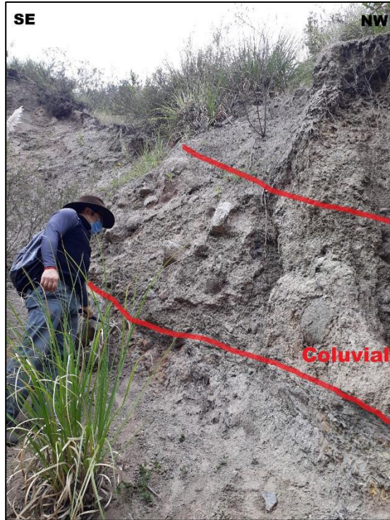
Fotografía 25 Coluvial asociado al deslizamiento Reactivado, UTM 751159 – 9893304 (Foto: K. Arequipa - EPN).
