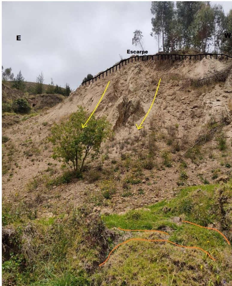
Fotografía 42 Deslizamiento pequeño activo las flechas amarillas indican la dirección del movimiento del coluvial, las líneas tomates indican las grietas transversales que indican el movimiento constante del deslizamiento, (Foto: K. Arequipa – EPN).
