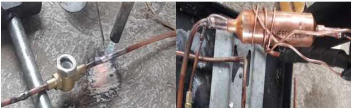
Figura 3.22 Unión de visor, filtro y tubo capilar.
