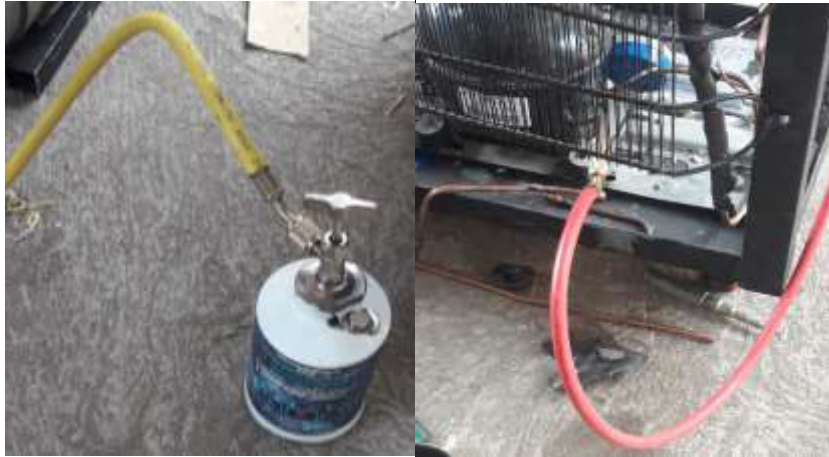
Figura 3.29 Carga de refrigerante R-134a.
