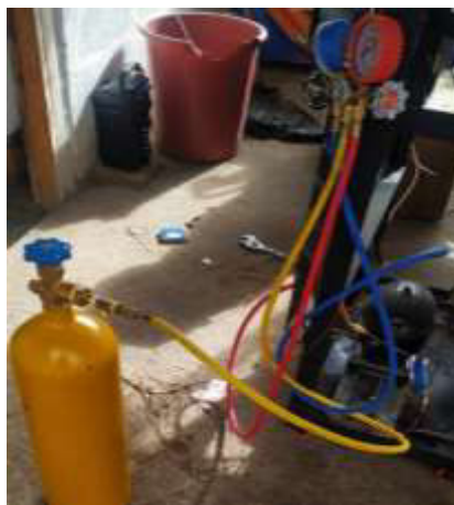
Figura 3.24 Presurización con nitrógeno.
