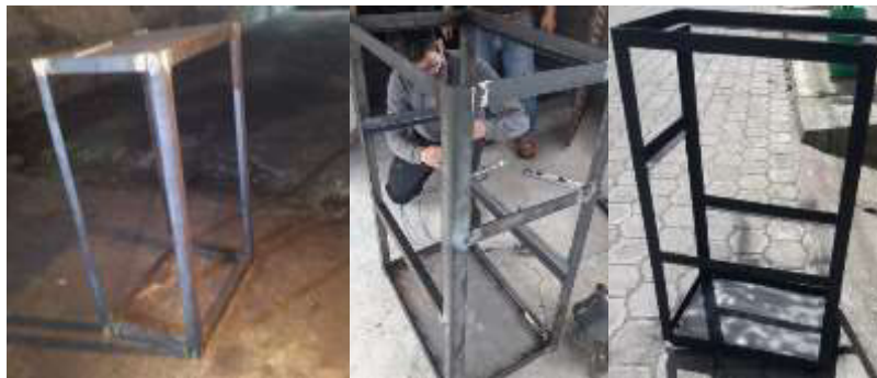
Figura 3.12 Ensamble de la estructura del módulo didáctico.
