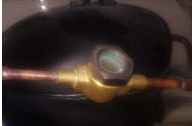
Figura 3.4 Visor de refrigerante.
