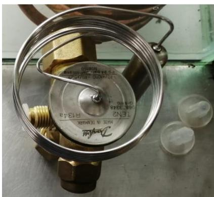
**Figura 3.12** Válvula de expansión termostática "VET" TENU2 DANFOSS [19].
