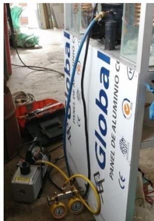
**Figura 3.36** Generación de vacío con bomba.
