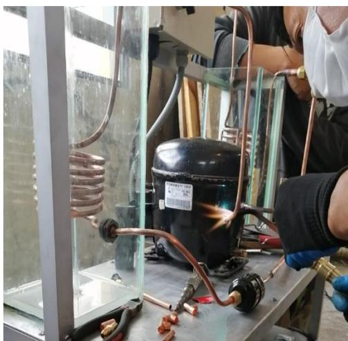
**Figura 3.32** Soldadura a la succión del compresor.
