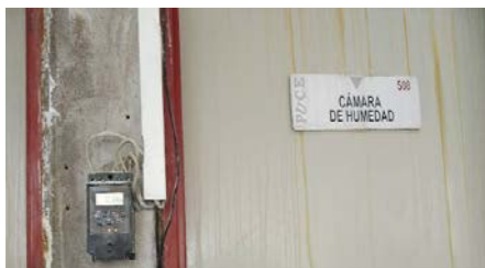
Fotografía 10: Cámara de humedad - PUCE.
