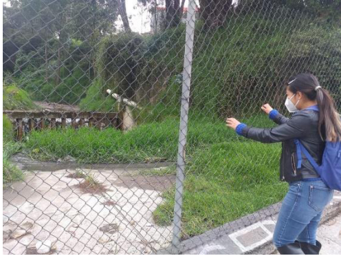
Figura 15 Cerramiento de la quebrada punto P1
