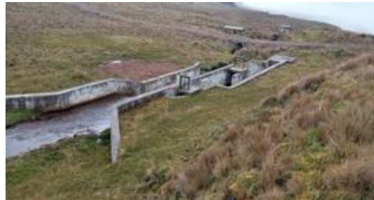
Figura 3. Captación microcuenca I
