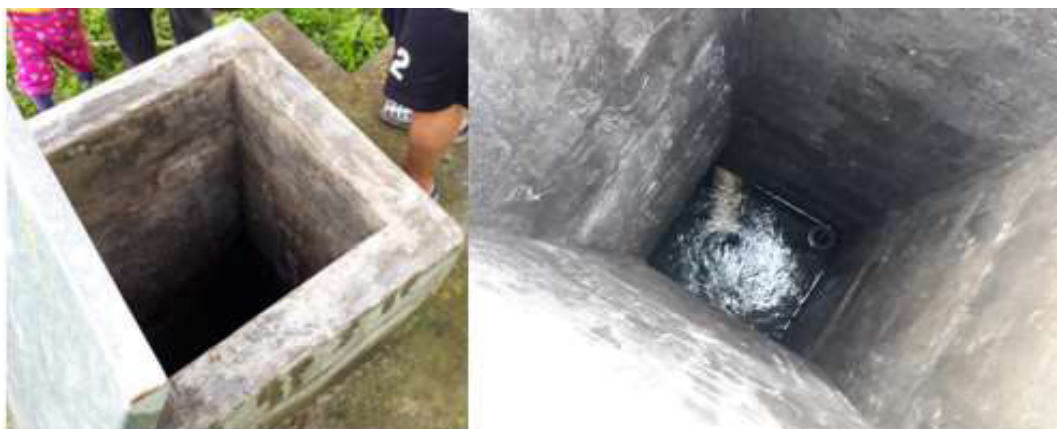
Figura 5. Parte interna del ojo de agua
