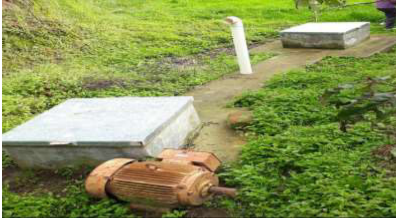
Figura 51. Tanque de captación
