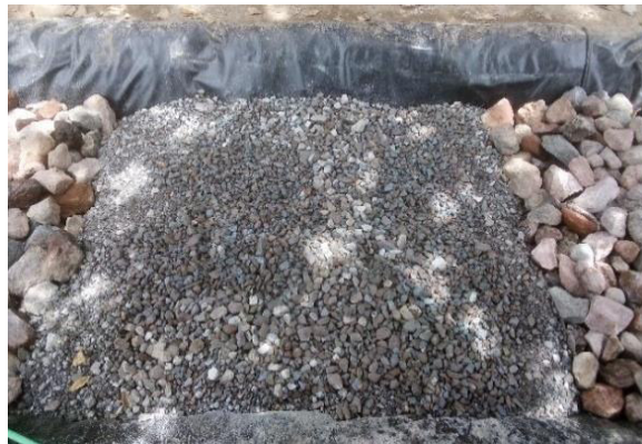
Figura 52. Colocación del material granular
