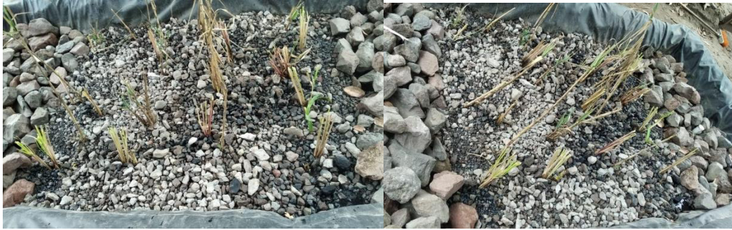
Figura 54. Colocación de plantas alrededor de la biojardinera
