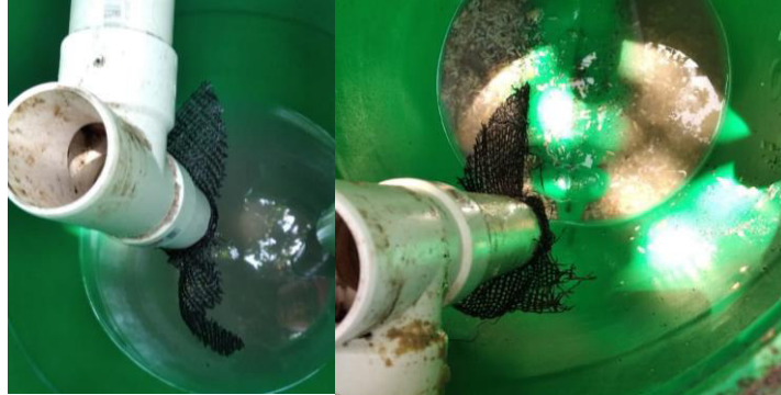
Figura 48. Colocación de malla en tubos de salida del pretratamiento
