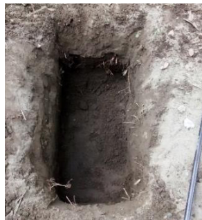
Figura 22. Excavación para los tanques del pretratamiento
