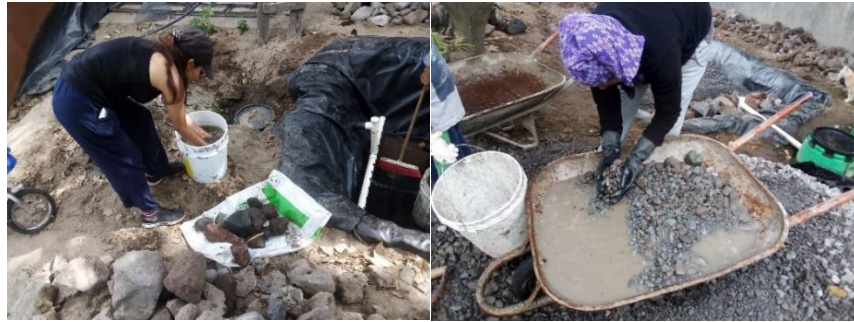
Figura 51. Lavado sustrato granular
