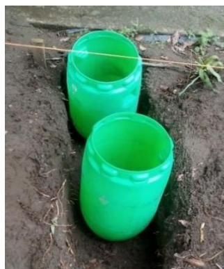
Figura 23. Colocación de tanques
