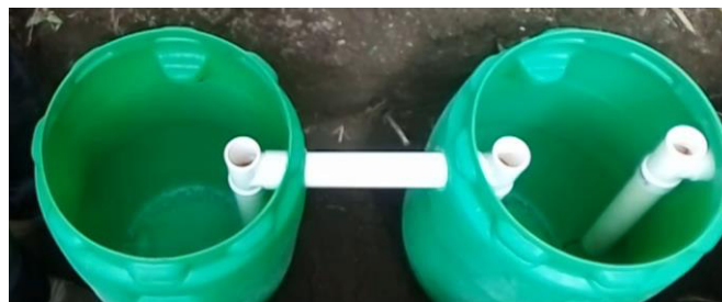
Figura 26. Adaptación de tuberías en los tanques
