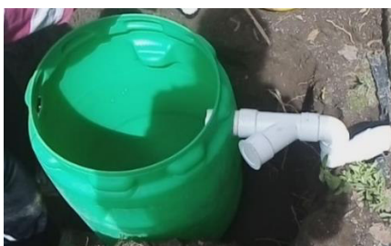
Figura 27. Construcción de sifón
