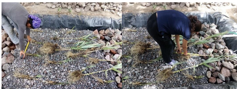
Figura 38. Colocación de vegetación en la biojardinera
