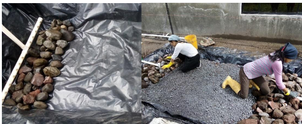
Figura 35. Colocación del sustrato granular
