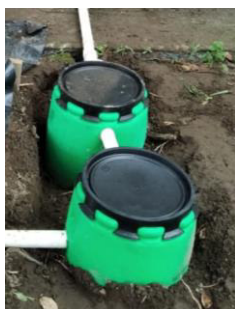
Figura 28. Relleno y culminación de la implementación del pretratamiento
