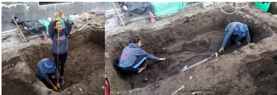
Figura 31. Nivelación del área del humedal
