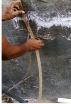
Figura 18. Tomando distancia de referencia para la nivelación
