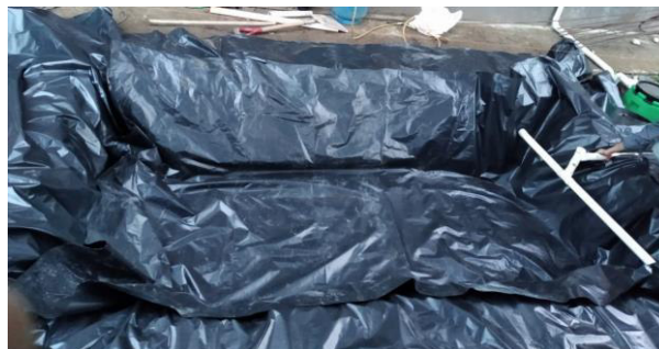
Figura 32. Colocación del material impermeable
