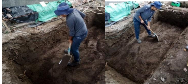
Figura 30. Excavación para el humedal
