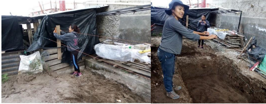
Figura 21. Colocación de estacas y piolas para las dimensiones del sistema
