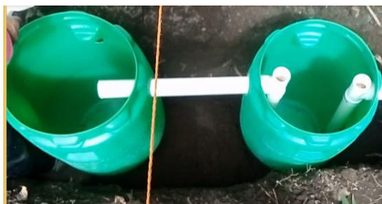
Figura 10. Adecuación de tanques para el pretratamiento
