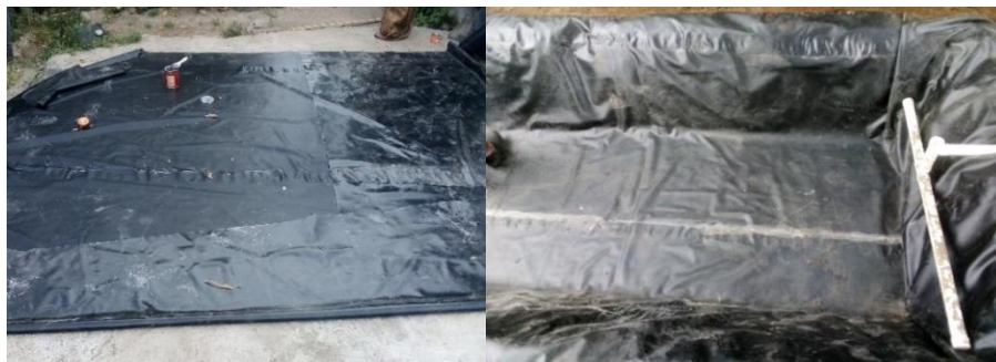
Figura 50. Colocación de geomembrana
