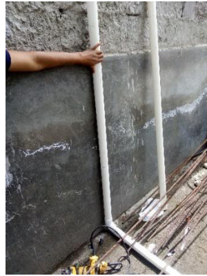
Figura 24. Implementación de tuberías
