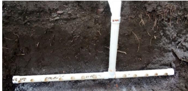
Figura 33. Perforación e instalación de tuberías
