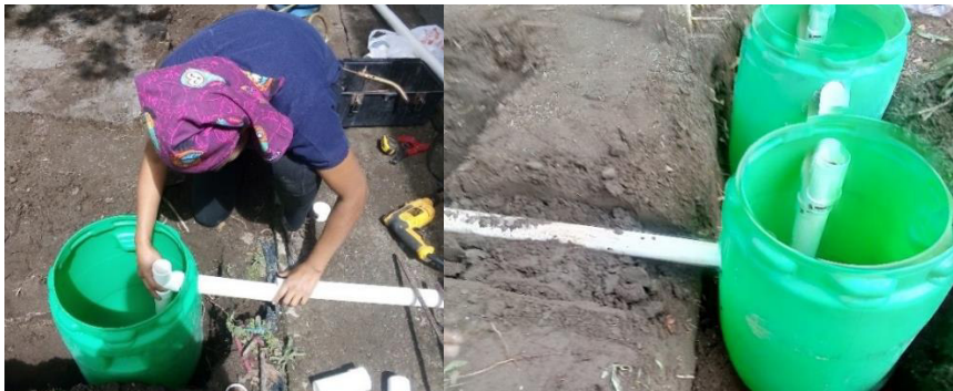
Figura 25. Adaptación de tuberías en los tanques
