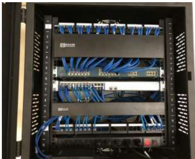
Figura 3.26 Resultado final rack de telecomunicaciones
