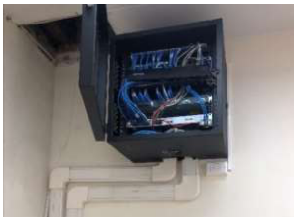
Figura 3.8 Abertura para enlace de backbone
