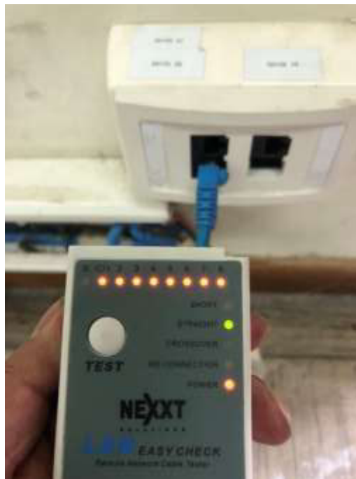
Figura 3.16 Testeo de puntos de datos
