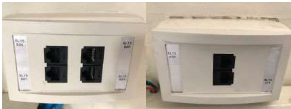
Figura 3.20 Etiquetado de face plates
