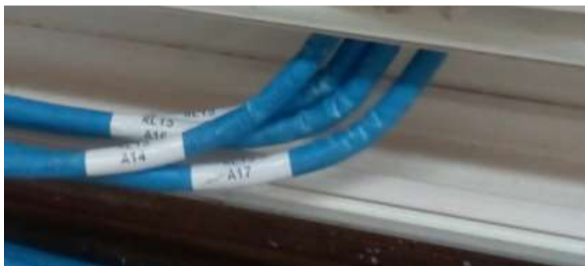
Figura 3.19 Seguimiento y etiquetado de cables hacia áreas de trabajo
