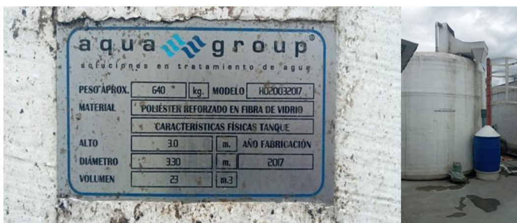
Figura 7 Especificaciones técnicas tanque de homogenización
