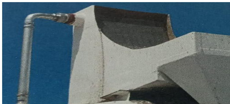
Figura 6 Tamiz retención de finos
