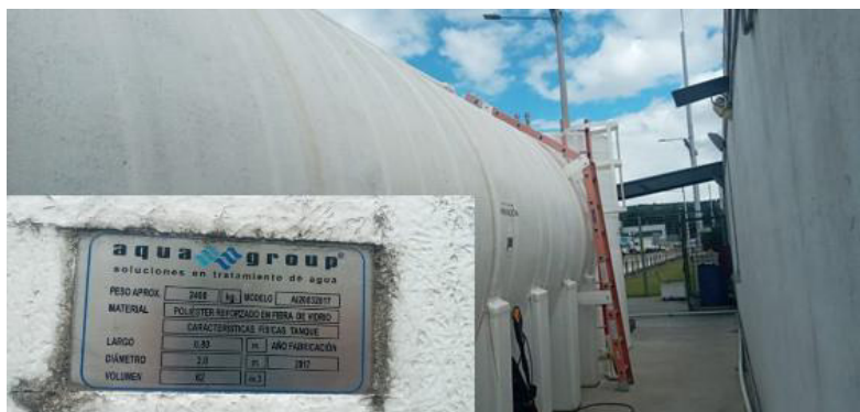
Figura 8 Especificaciones técnicas tanque de aireación
