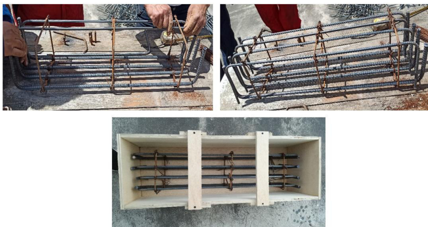
Figura 34 Armado de vigas
