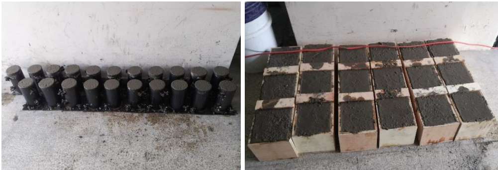
Figura 37 Moldeo de cilindros y vigas de hormigón simple
