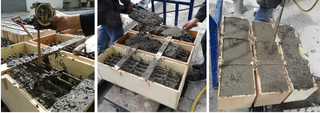
Figura 38 Moldeo de vigas de hormigón armado
