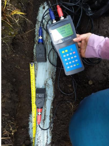
Figura 7. Medición de caudal con medidor ultrasónico
