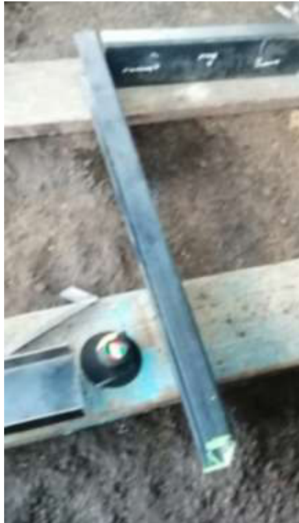
Figura 3.14 Estructura metálica lateral
