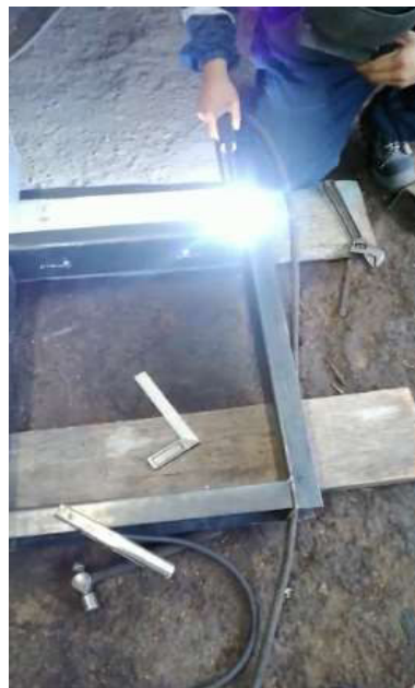
Figura 3.22 Unión de la estructura de soporte para el molde hembra
