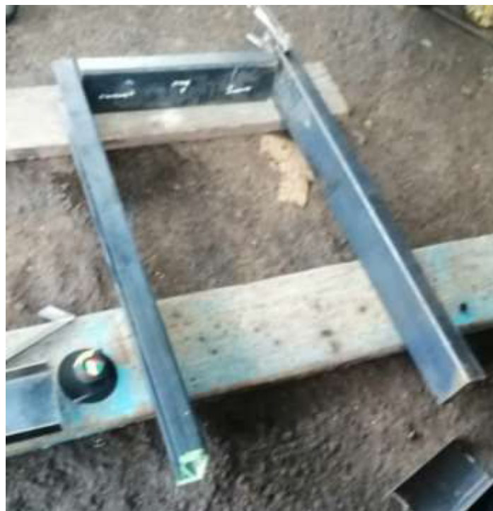
Figura 3.20 Segundo proceso de suelda estructuras laterales
