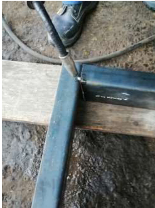
Figura 3.19 Proceso de suelda estructuras laterales
