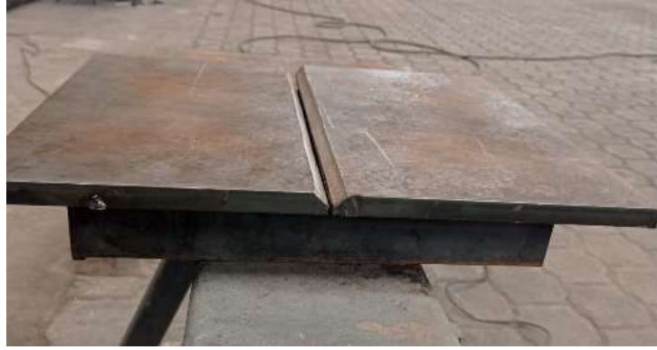
Figura 2.2. Colocación de pletinas guía para mantener la distancia entre placas. (Fuente: Propia)
