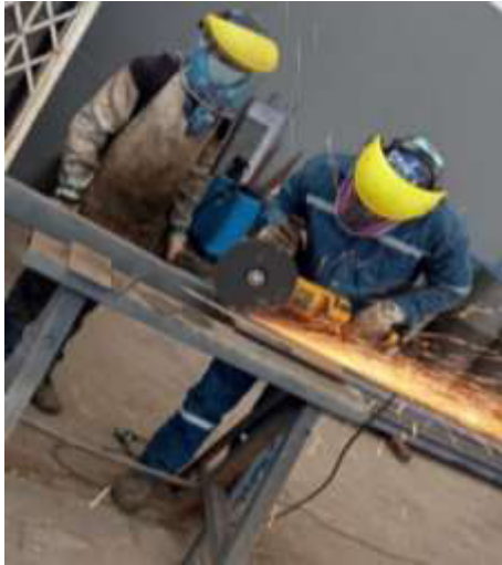
Figura 2.6. Desbaste del cordón en un proceso de reparación. (Fuente: Propia)
