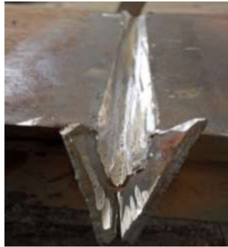
Figura 2.7. Cordón desbastado, con limpieza previa al resoldeo. (Fuente: Propia)
