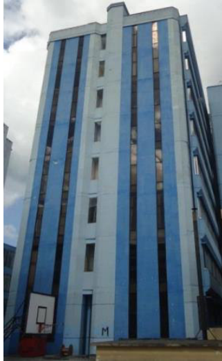
Figura 3.1 Edificio Química Eléctrica.
