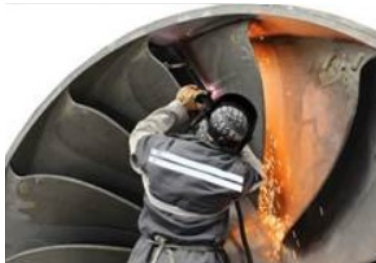
Figura 5 Corte plasma en el área afectada de los alabes. (Fuente: [9])
