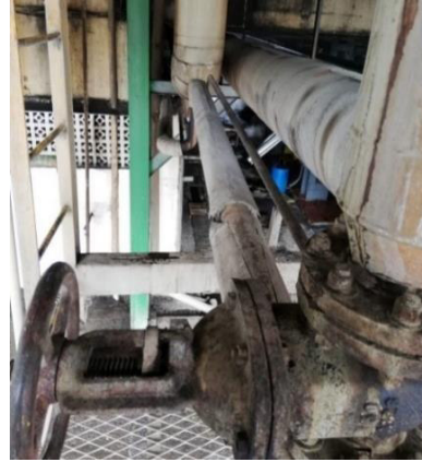
Figura 9. (a) Bombas de condensado a la caldera (b) Tubería principal de condensados del pre-evaporador (Fuente: Propia).
