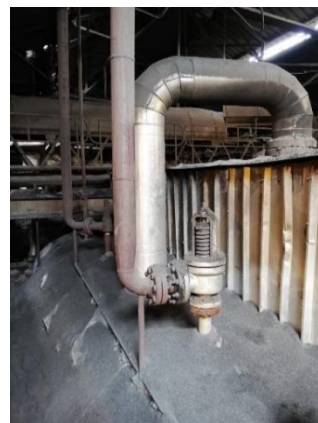
Figura 11. (a) Falla por abrasión (b) Válvula de seguridad domo superior. (Fuente: Propia)
