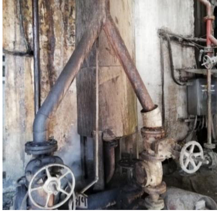
Figura 9. (a) Bombas de condensado a la caldera (b) Tubería principal de condensados del pre-evaporador (Fuente: Propia).
