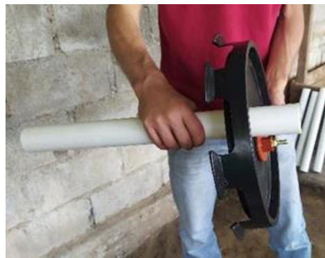
Fotografía 2.2.1.5 Instalación de tubo de monitoreo y salida de gas
