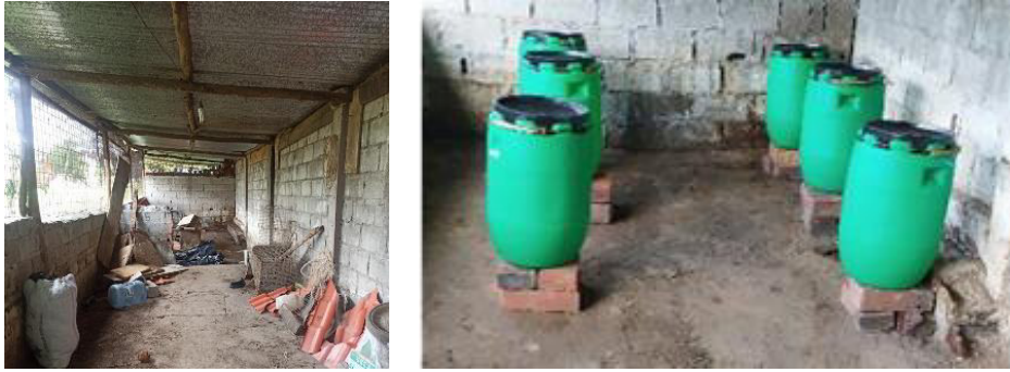
Fotografía 2.2.1.1 Área de instalación de tanques.
