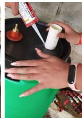
Fotografía 2.2.1.5 Instalación de tubo de monitoreo y salida de gas
