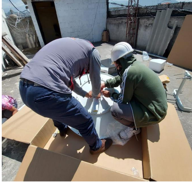
Figura 3.22 Colocación de las protecciones
