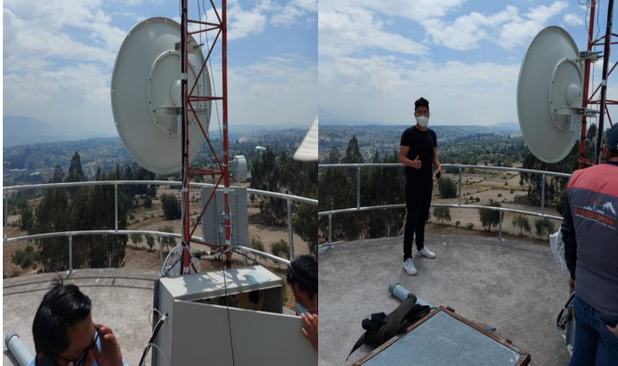
Figura 3.32 Colocación de la antena en el módulo “11 de noviembre”
