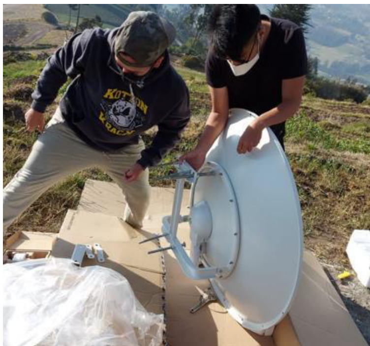
Figura 3.29 Ajuste de la base de la antena
