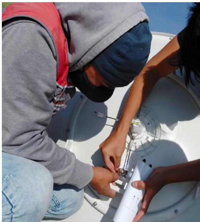
Figura 3.26 Colocación de la radio Mimosa C5c
