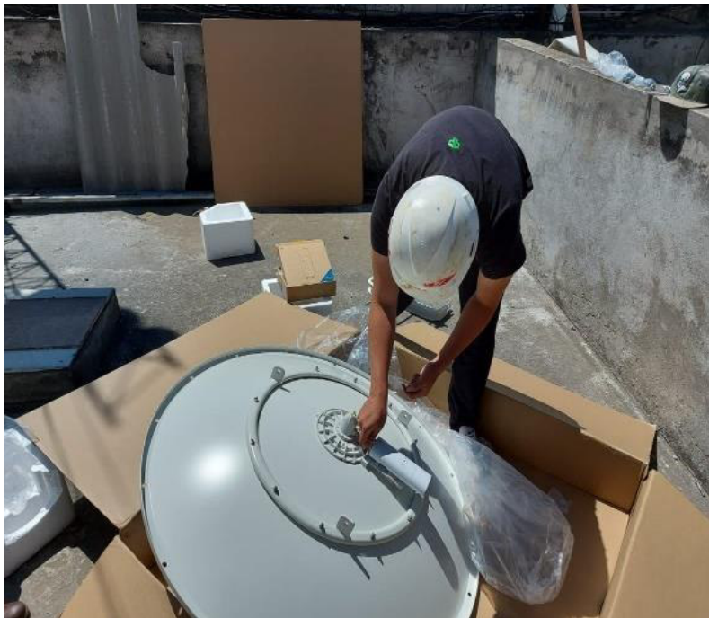
Figura 3.21 Colocación de la radio Mimosa C5c
