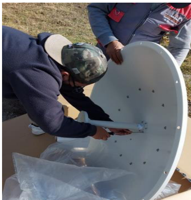
Figura 3.24 Ajuste de la antena con el platillo
