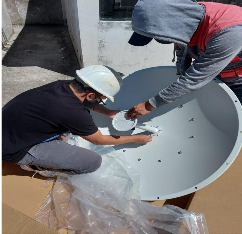
Figura 3.20 Ajuste de la antena en el platillo
