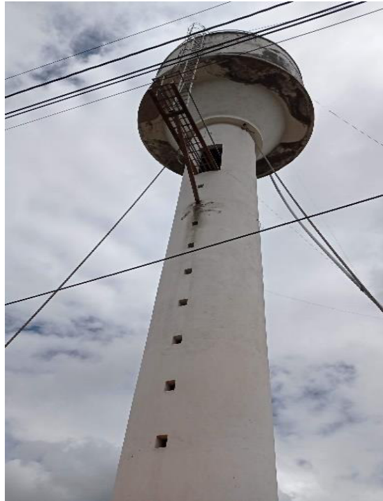
Figura 3.30 Tanque “11 de noviembre” parte inferior
