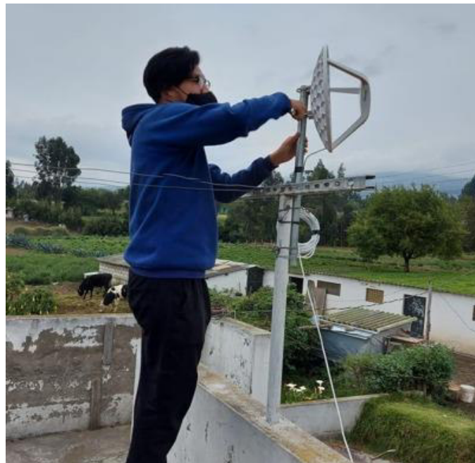
Figura 3.46 Alineación de la antena
