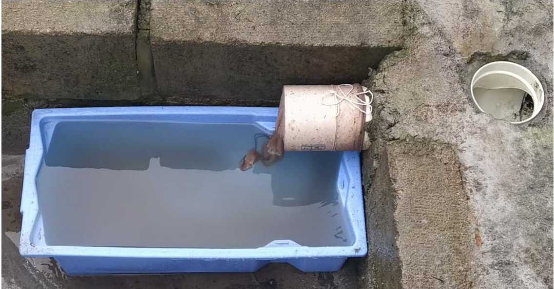
Figura A.IV.6 Aguas grises previo a descarga de suero de leche
