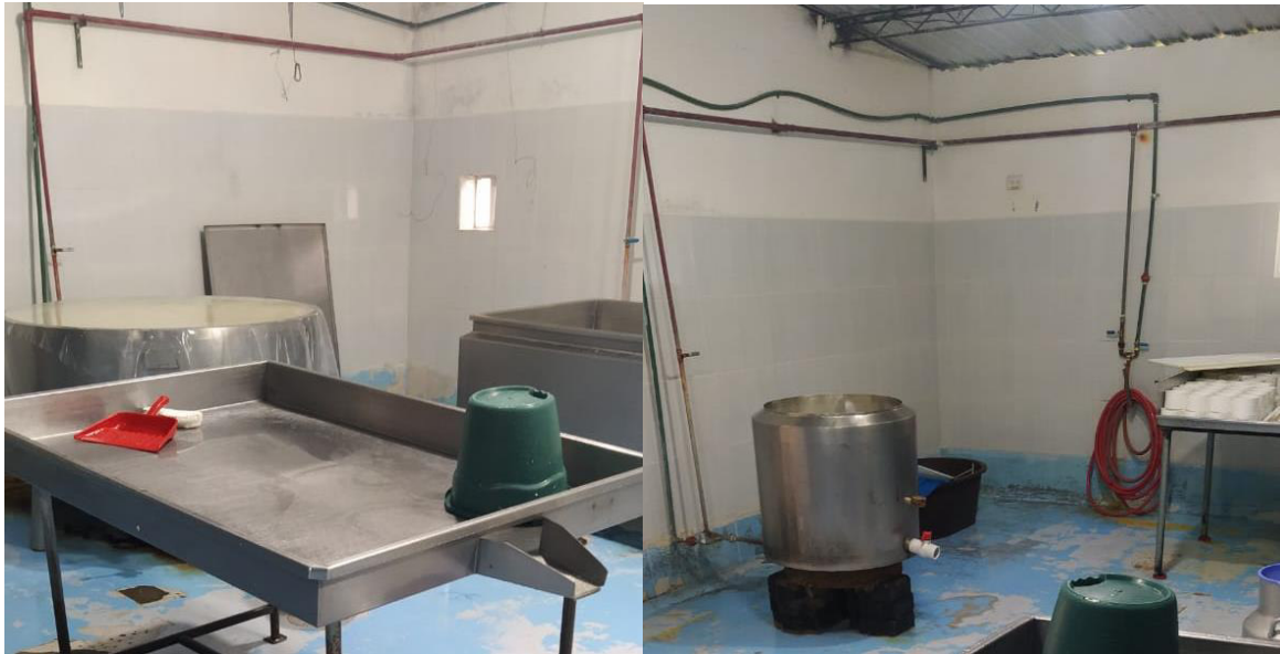
Figura A.IV.1 Instalaciones de la planta de producción 1
