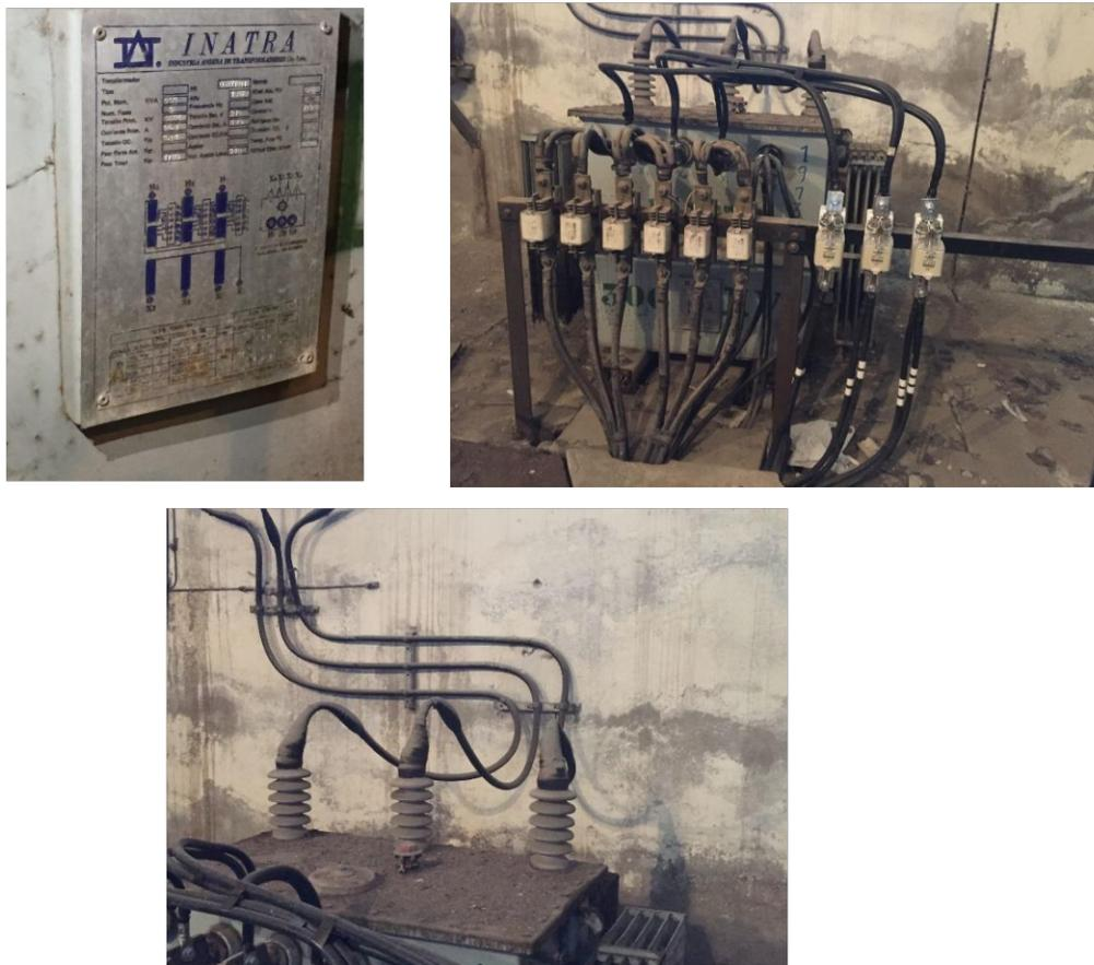
**Figura 2.** Transformador INATRA de la red de la EEQ
