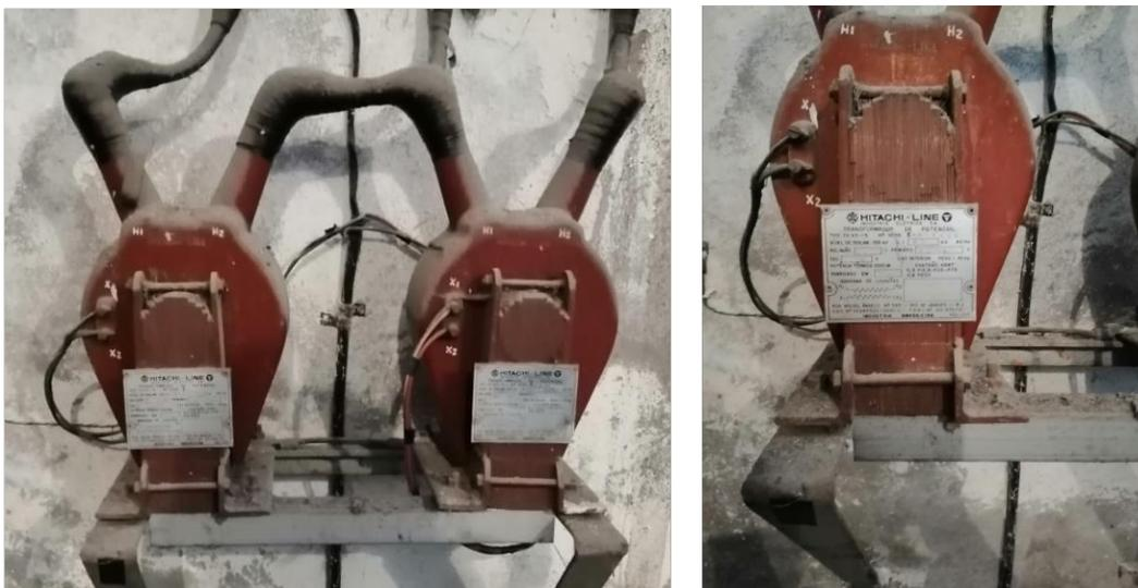
**Figura 4.** Transformadores de potencial
