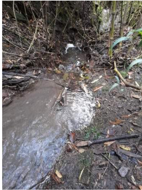
Figura 2.10: Punto 4 cercano a la depresión de la obra hidráulica
