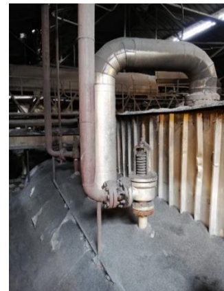
Figura 19. (a) Falla por abrasión (b) Válvula de seguridad domo superior. (Fuente: Propia)
