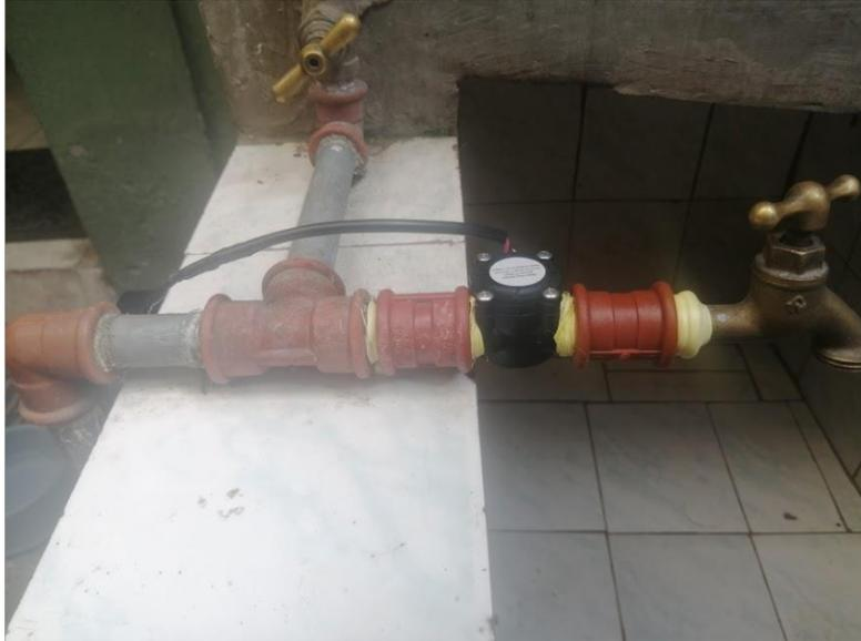
**Figura 2.6** Sensor de caudal instalado en lavandería
