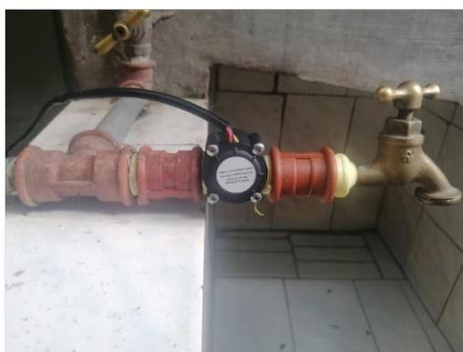
**Figura I.3** Sensor de caudal conectado a la tubería
