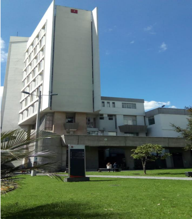
Figura 33. Edificio Administrativo - fachada lateral Fuente: elaboración propia
