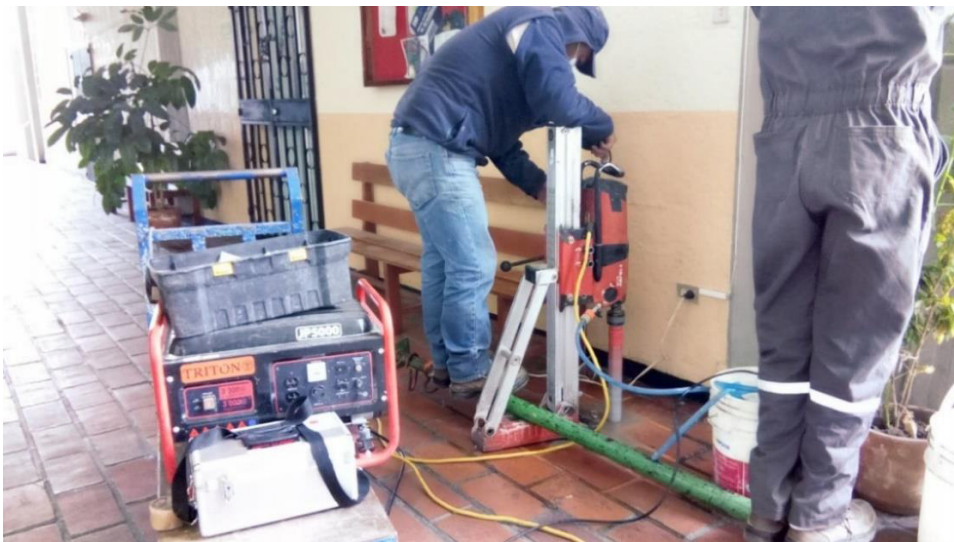
Figura 44. Extracción de núcleos de losas Fuente: elaboración propia
