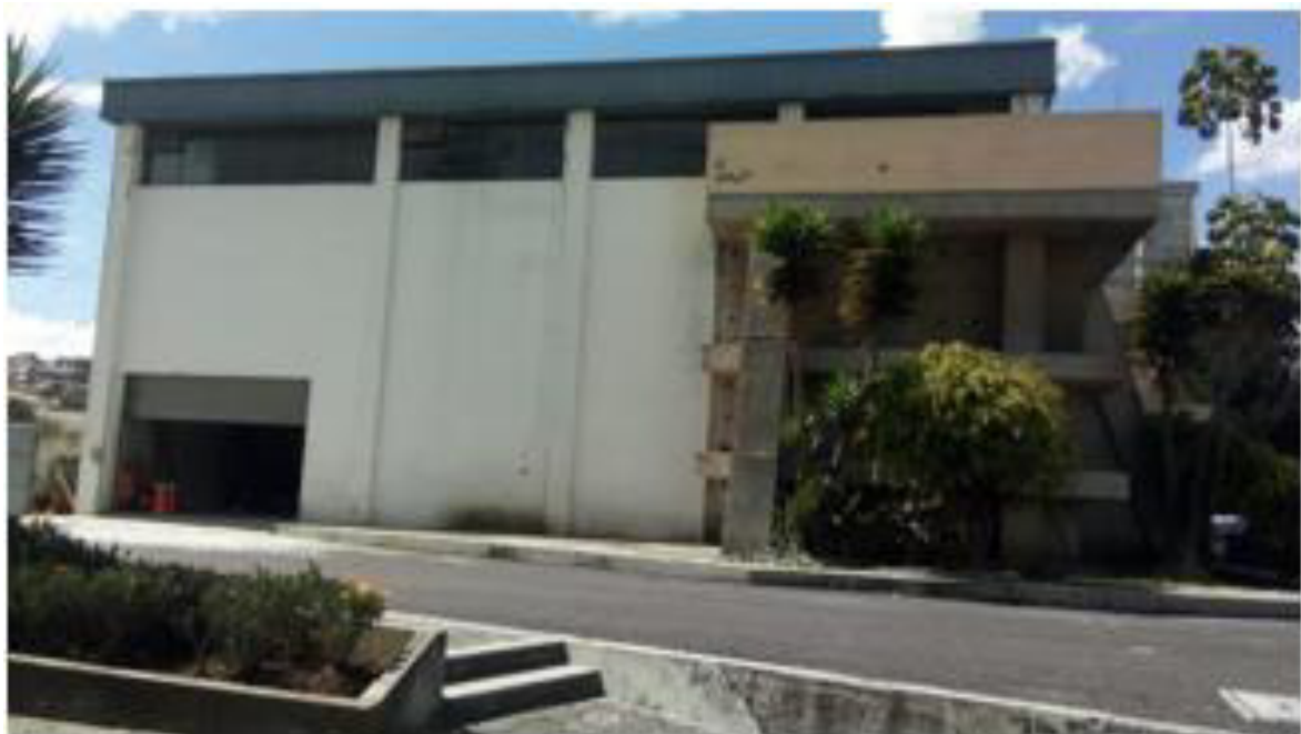
Figura 31. CIV- fachada lateral Fuente: elaboración propia
