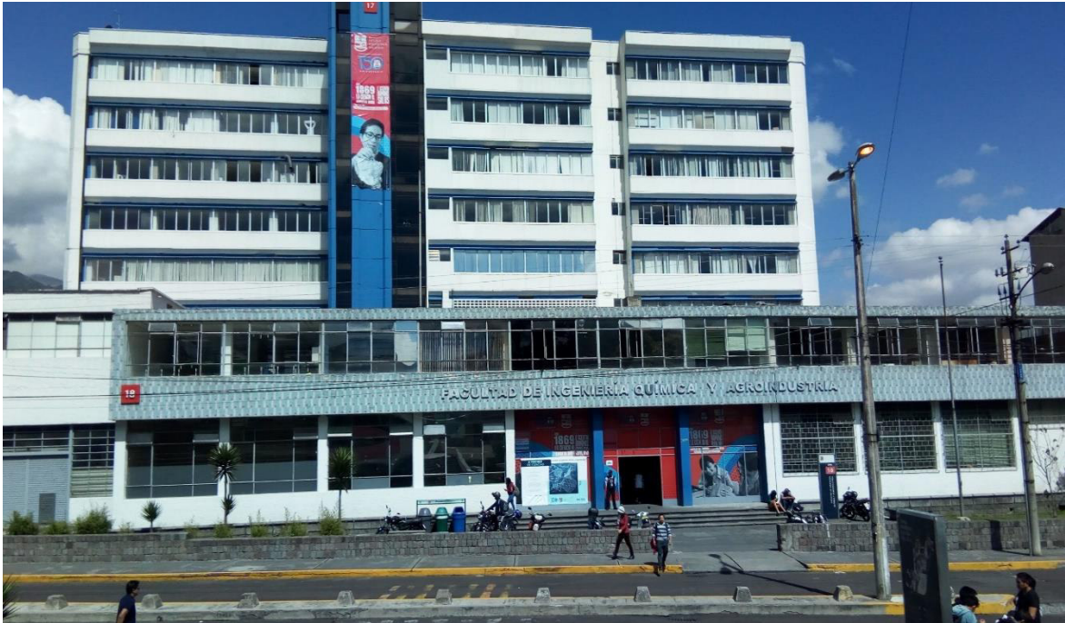
Figura 34. Edificio Química/Eléctrica - fachada frontal Fuente: elaboración propia
