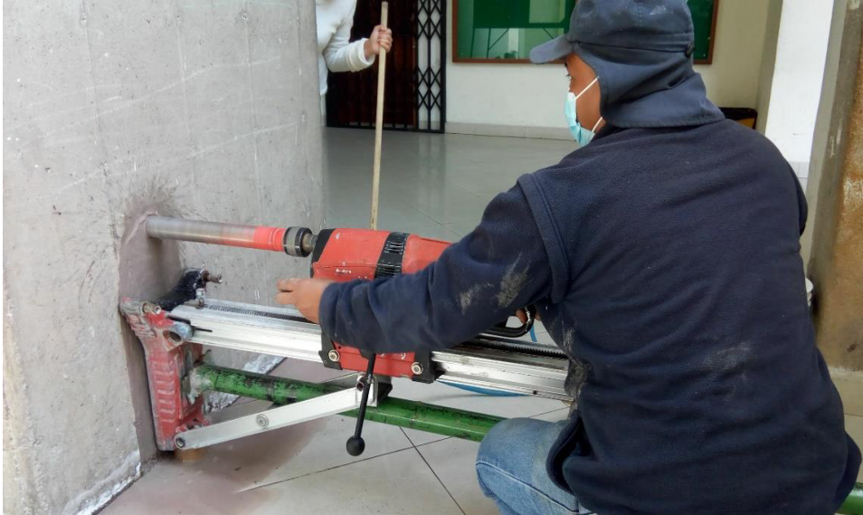
Figura 43. Extracción de núcleos de columnas, muros y vigas Fuente: elaboración propia
