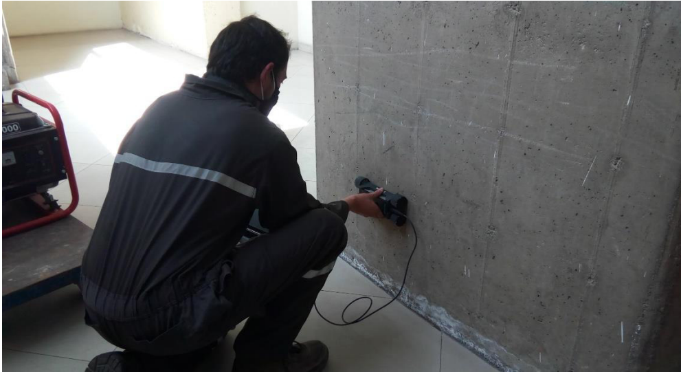
Figura 42. Detección de la armadura de refuerzo
