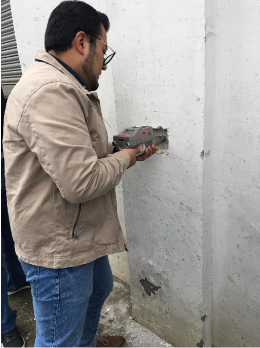
Figura 37. Ensayo de rebote en una columna Fuente: elaboración propia
