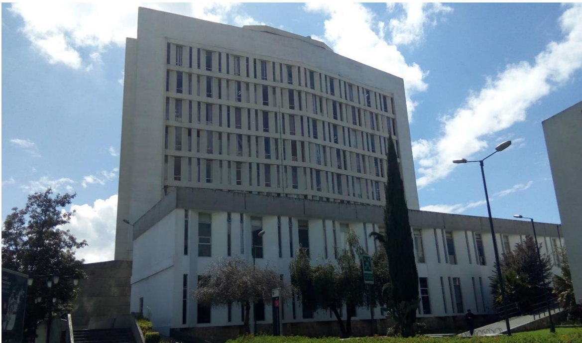
Figura 32. Edificio Administrativo - fachada frontal Fuente: elaboración propia
