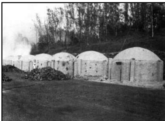
Figura 1.14. Horno de ladrillo. (Fuente: Guillen, 2008)
