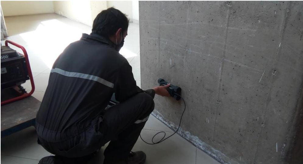
**Figura 42.** Detección de la armadura de refuerzo
