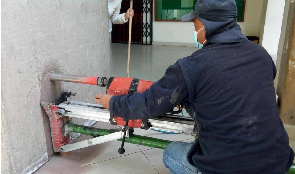
**Figura 43.** Extracción de núcleos de columnas, muros y vigas
