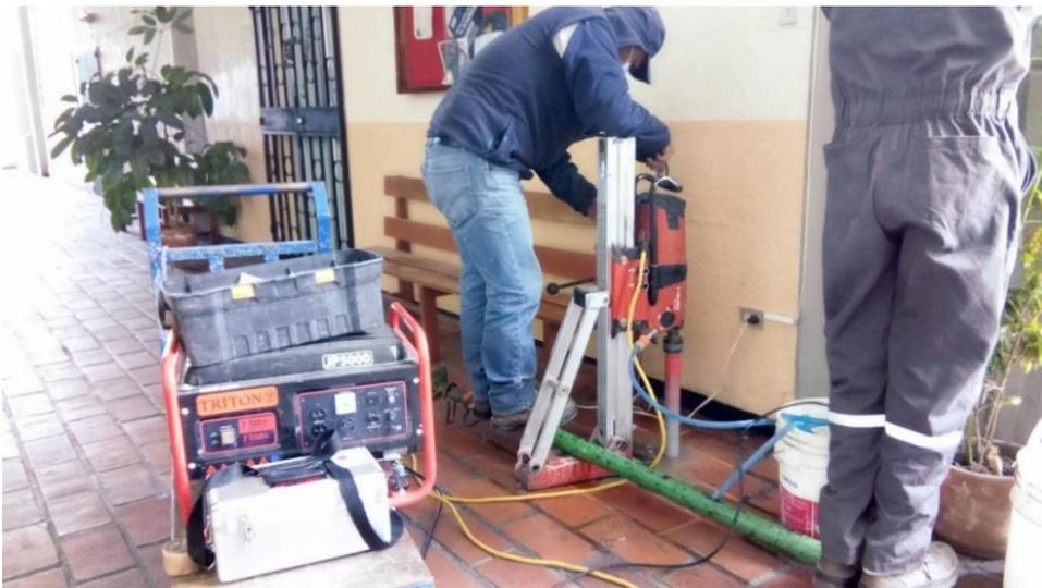
**Figura 44.** Extracción de núcleos de losas
