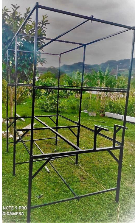
Figura 2.6. Construcción de Estructura Física
