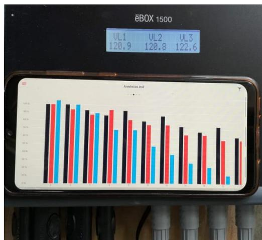
**Figura 4.18.** Espectro de armónicos con datos de voltaje línea neutro [ELABORACION PROPIA].
