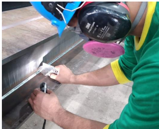
Figura 1.17 Inspección visual de soldadura.
