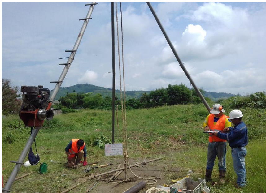
Figura 3.8. Tripodes de perforación utilizados en los sondeos SPT-1 y SPT-2.
